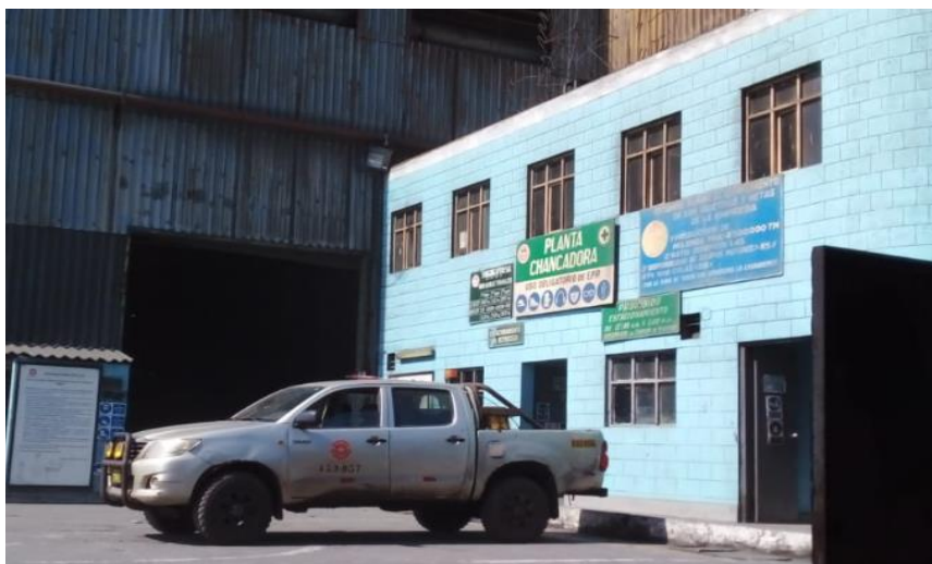
Figura 17. Planta chancadora área San Nicolás.
