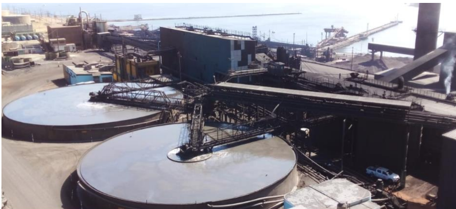
Figura 19. Planta de filtrado.
