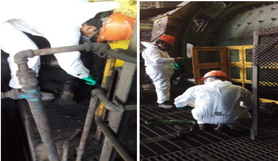
Figura 34. Aplicación de medidas correctivas.
