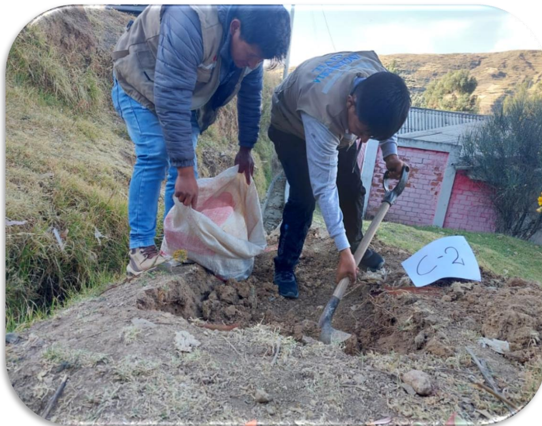
Foto N.8: obtención de tierra del terreno
