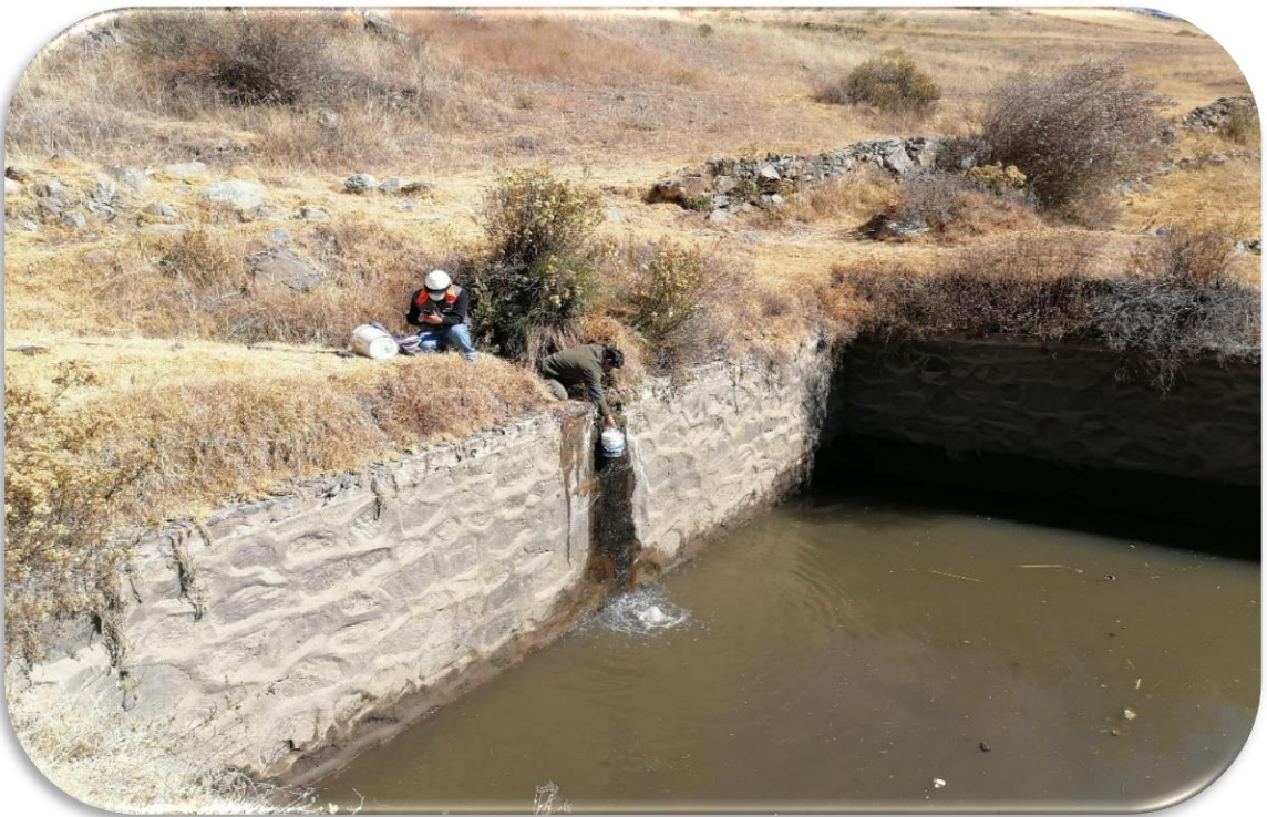
Foto N.6: obtención de datos de aforo de agua en la entrada del reservorio
