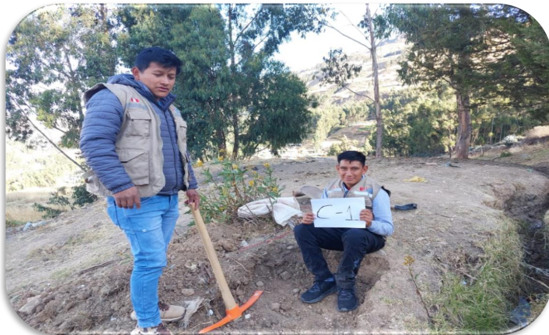
Foto N.7: excavación de calicata
