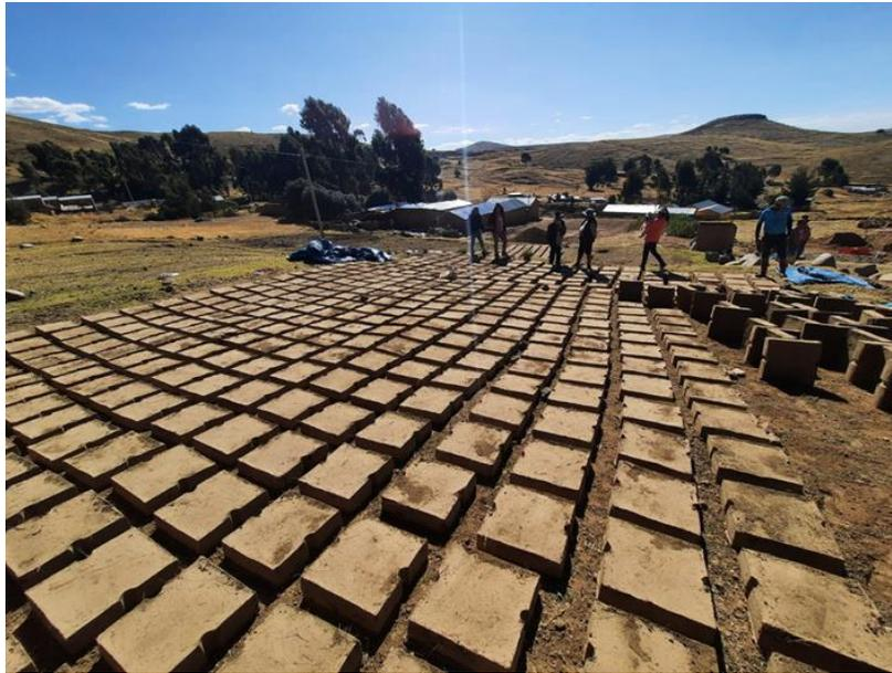
**Figura 2.** Moldeado y secado de bloques de adobe.
