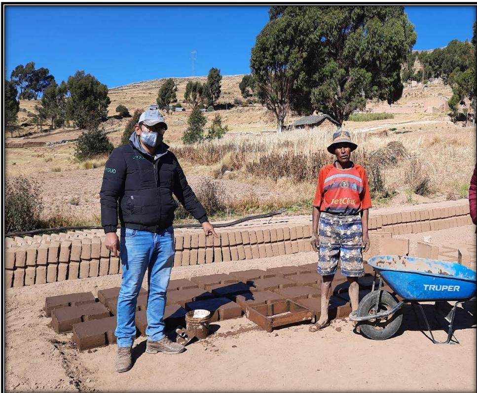
**Fotografía 6:** Proceso de Moldeo de los bloques de Adobe
