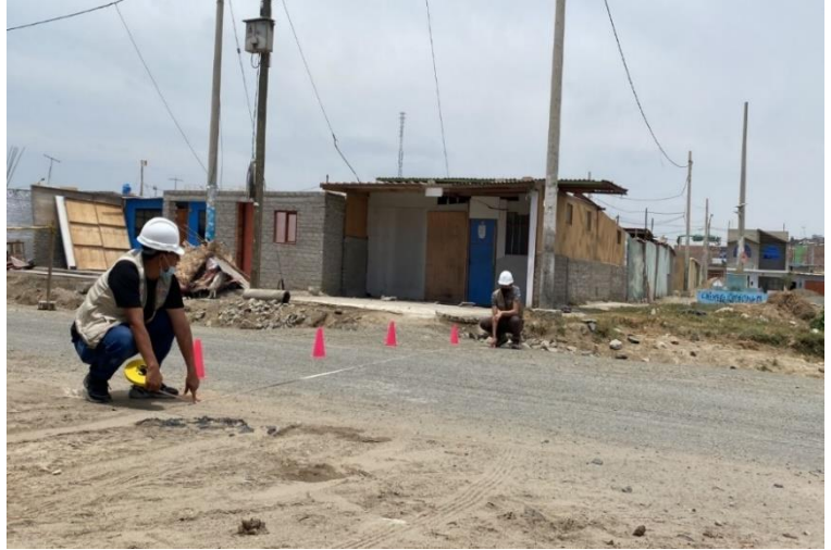
Progresiva 0+200 Medición del ancho de calzada.
