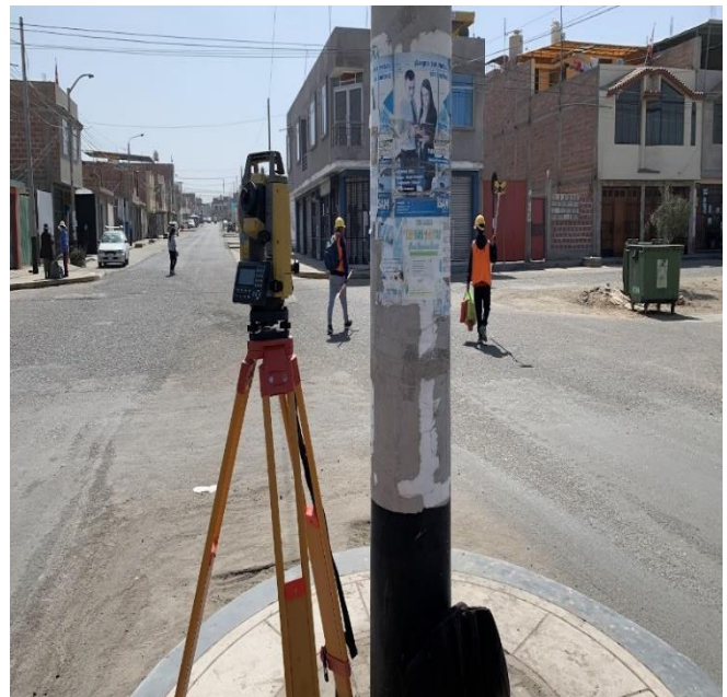
Foto 4: Observamos que para el levantamiento de los puntos topográfico se utilizó una estación total topcon modelo GM50, dos prismas y un GPS navegador.
