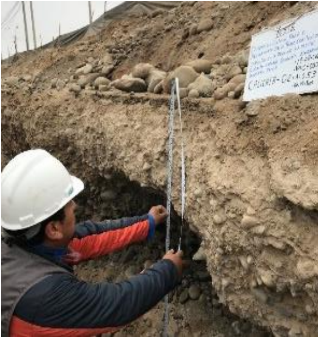
Foto 21: Observamos la medición de la profundidad de excavación para la calicata 02.
