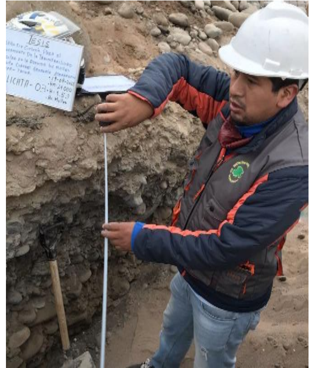
Foto 26: Se aprecia la altura de excavación h=1.53 metros.
