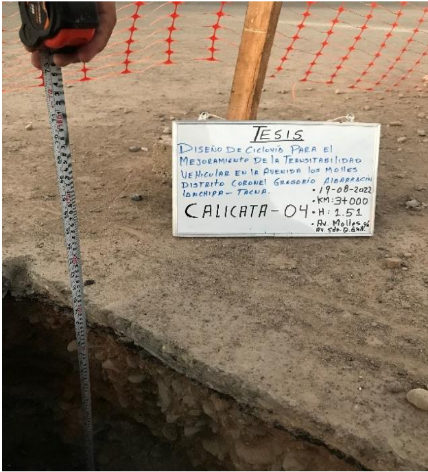
Foto 29: Observamos la extracción de muestra en la calicata 04 ubicada en el km 3+000
