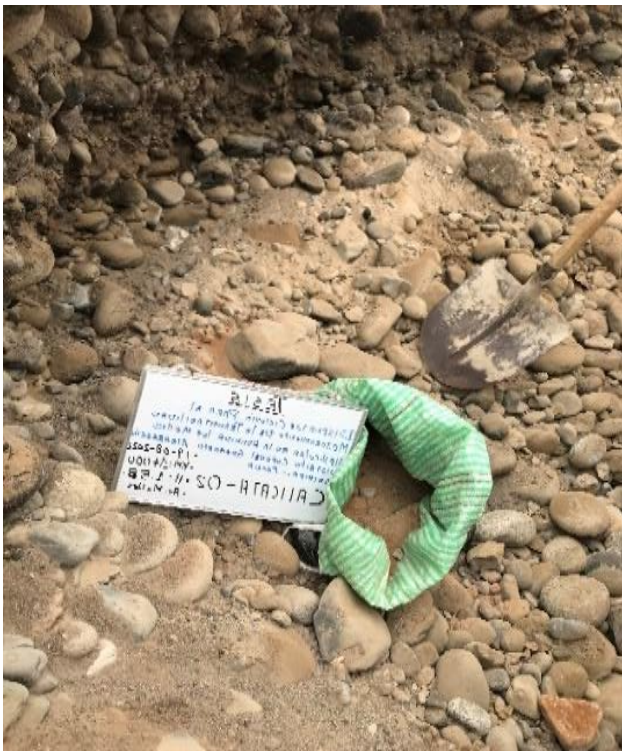
Foto 23: Se observa el material extraído de la calicata 02 a una profundidad de h = 1.5 metros.
