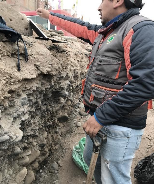
Foto 25: Se observa la exploración de la calicata 03 ubicada en el km 2+000
