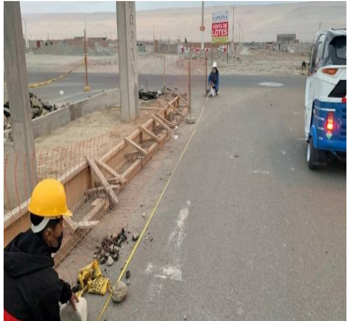
Foto 2: Observamos la medición del trayecto de la vía elegida para realizar el proyecto con la ayuda de la wincha.
