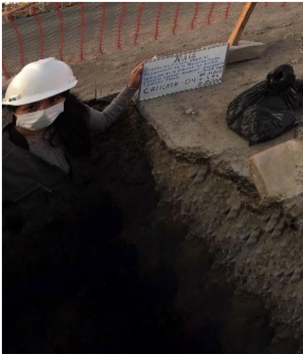
Foto 31: Se aprecia la extracción del material de la calicata 04 ubicada en el km 3+000
