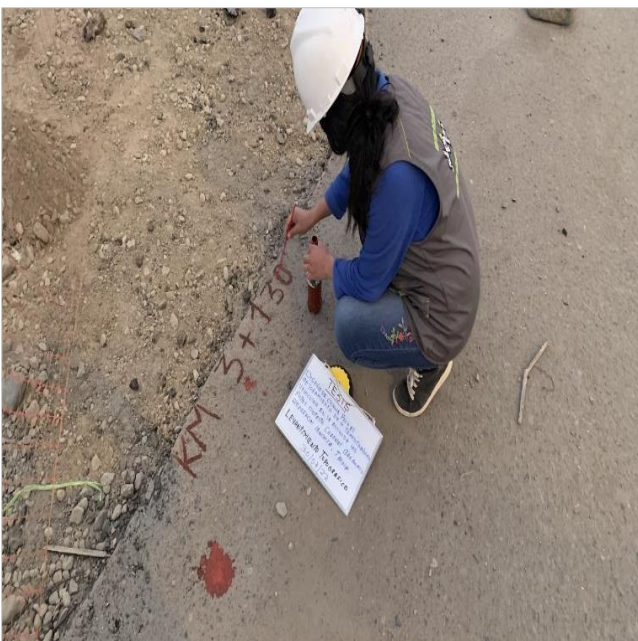
Foto 3: Observamos como se vino realizando el pintado de progresivas cada 20 metros.
