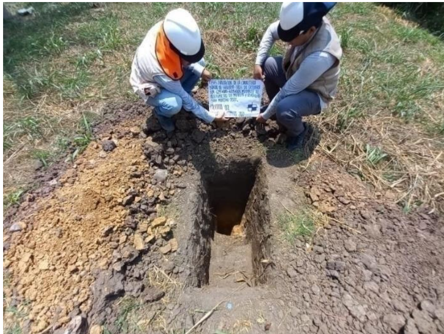
Foto N° 6: Excavación de calicata N° 2 ubicado en el Km. 627+900.
