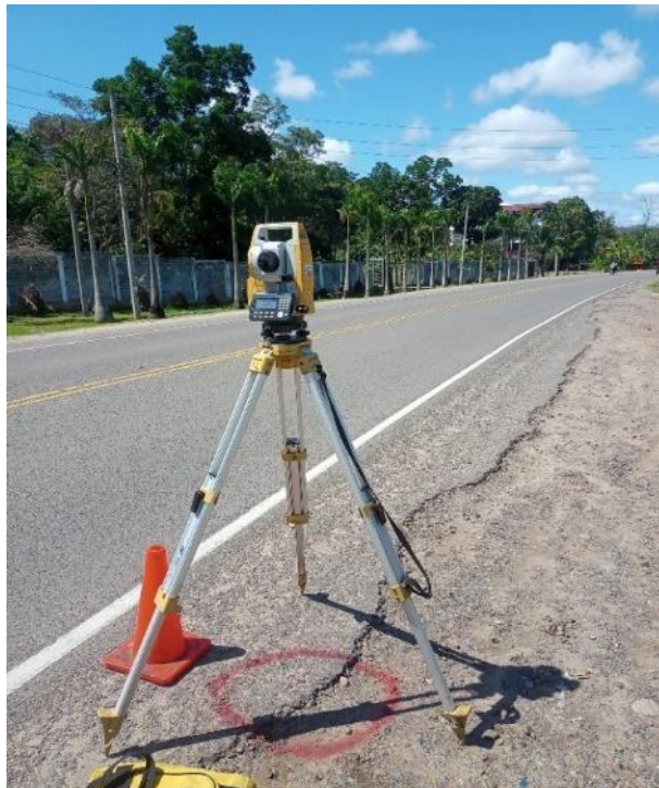
Foto N° 2: Armado y fijado de la estación total.
