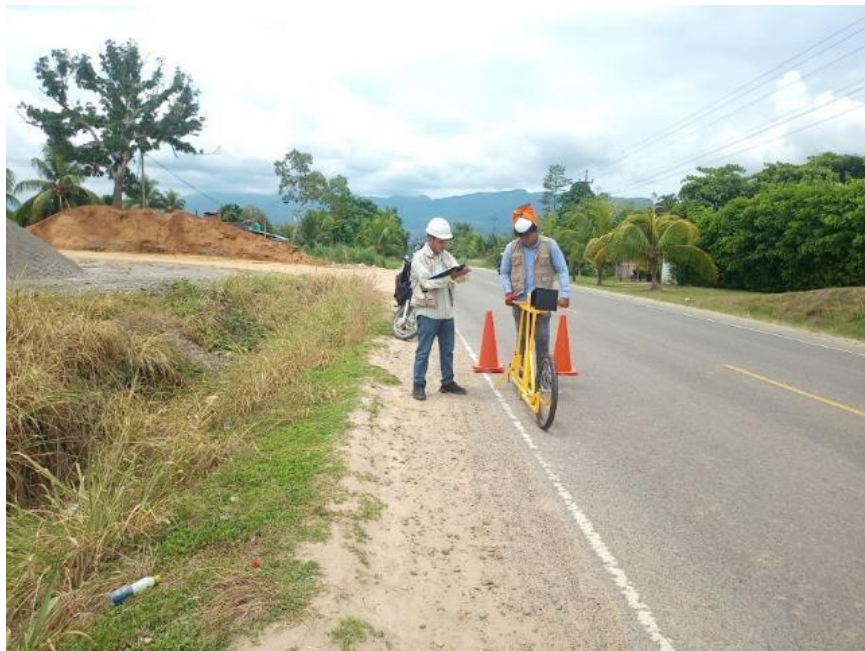
Foto N° 16: Toma de datos con el rugosímetro de Merlín en el carril derecho, de ida desde el Km. 625+000 hasta 629+000.
