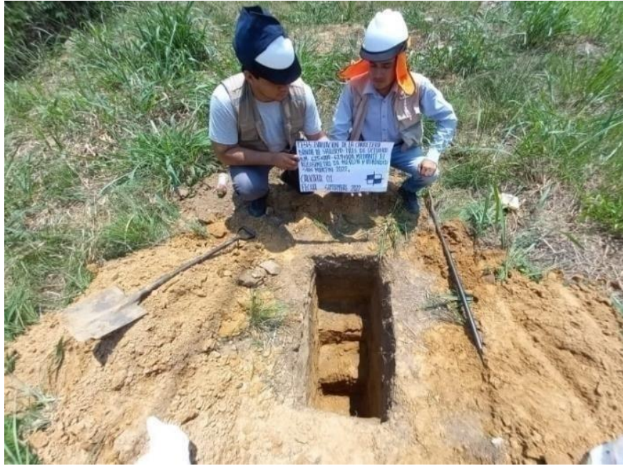
Foto N° 5: Excavación de calicata N° 1 ubicado en el Km. 625+350.
