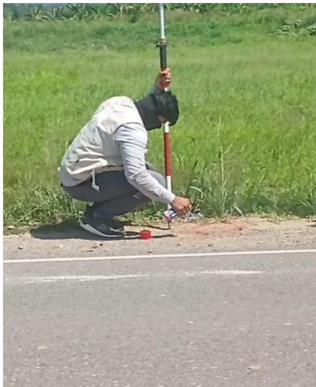
Foto N° 4: Marcado del punto para cambio de estación.
