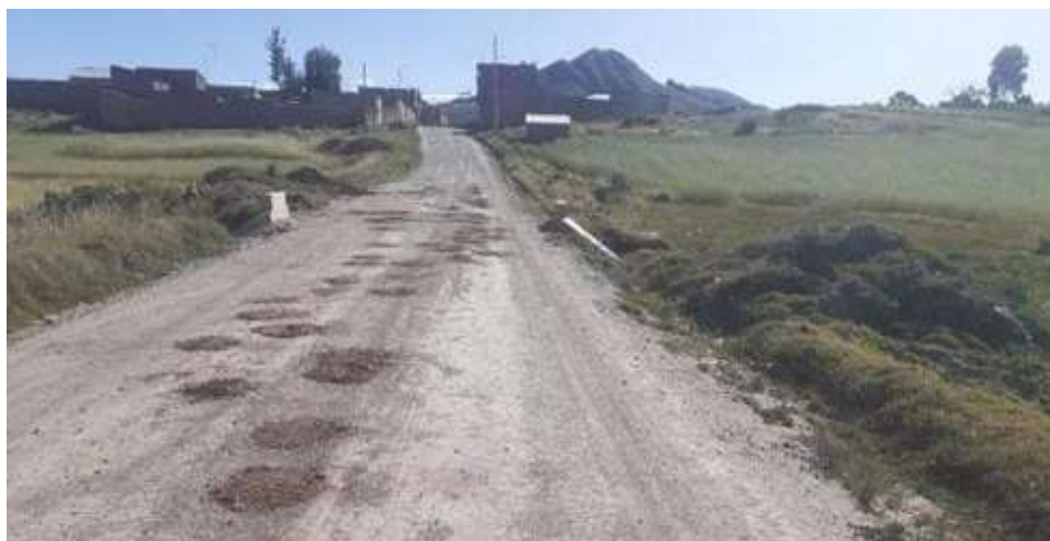
Figura 1. Superficie de la vía sin el tratamiento sello Otta Seal
