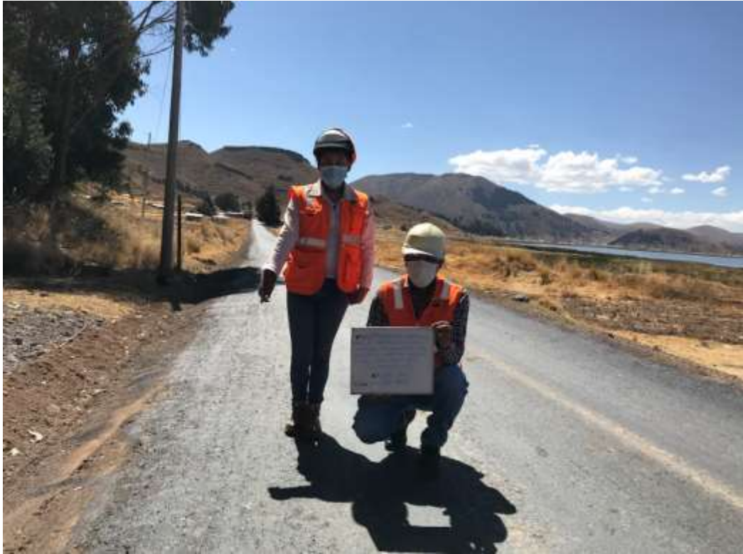
Figura 17. Imprimación asfáltica de la vía
