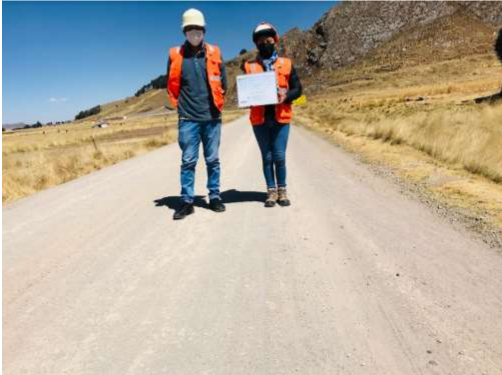
Figura 13. Superficie a nivel de afirmado Km 25+100
