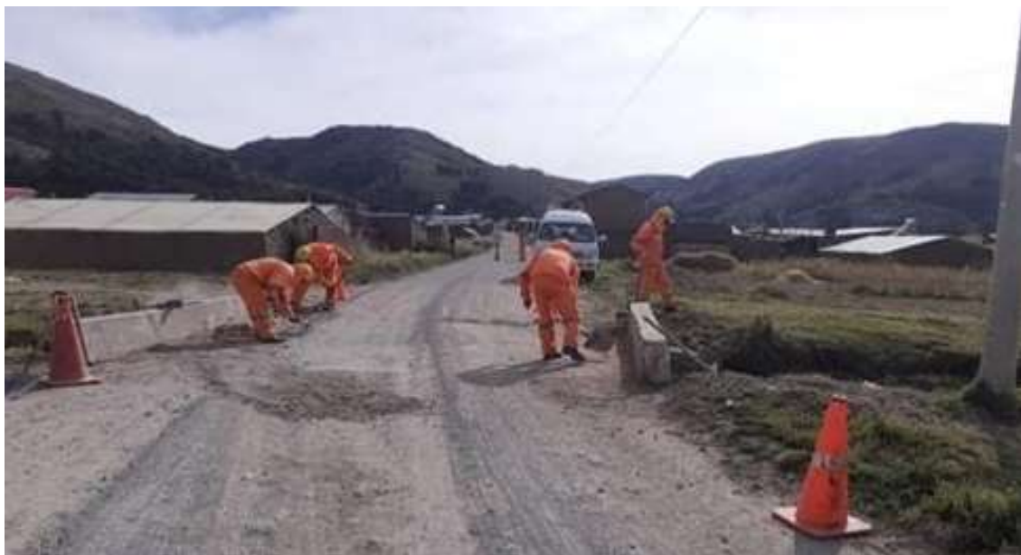
Figura 5. Ejecución de actividades de limpieza de la calzada
