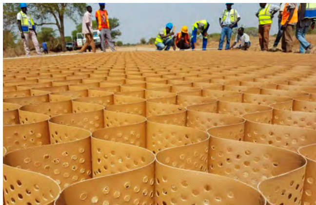
Figura 2. Estructura de una geocelda
