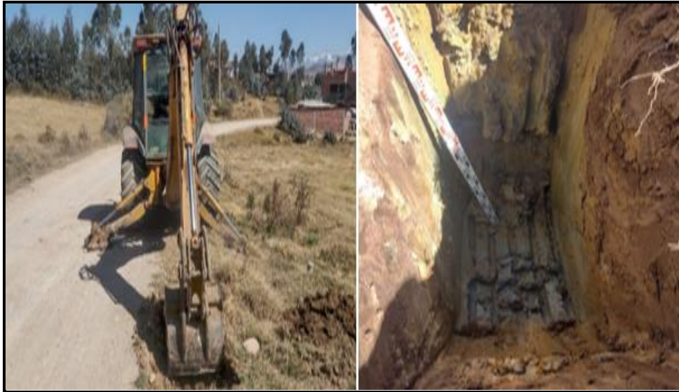
Figura 17: Excavación y retiro del material de Calicata 2 para pruebas en laboratorio
