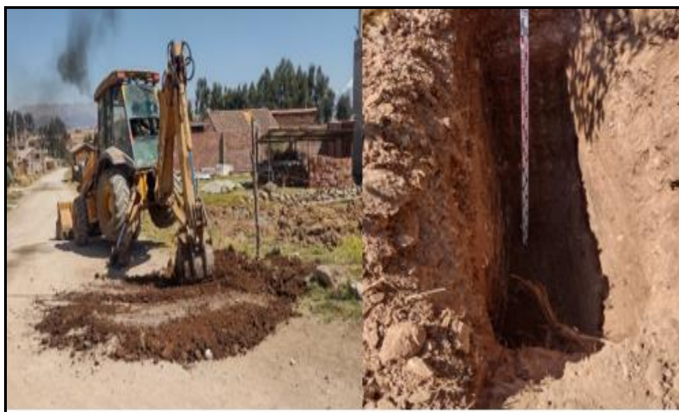
Figura 16: Excavación y retiro del material de Calicata 1 para pruebas en laboratorio
