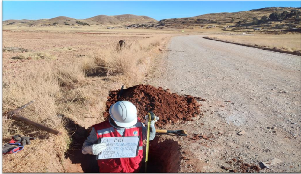
Fotografía 04: Extracción de la muestra de la calita C – 03 de la progresiva Km. 20 + 250; margen izquierdo.
