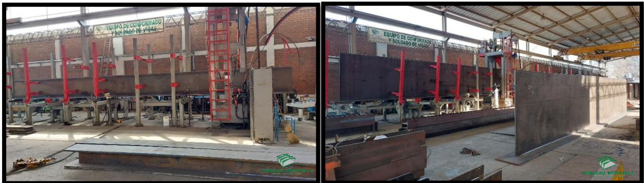
Figura 14. Proceso de soldeo antes / después
