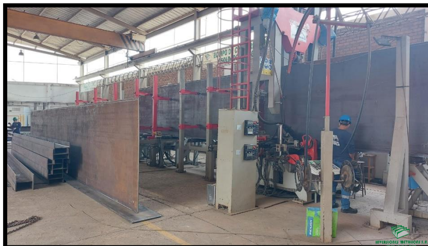
Figura 17. Proceso de soldeo de vigas en pares
