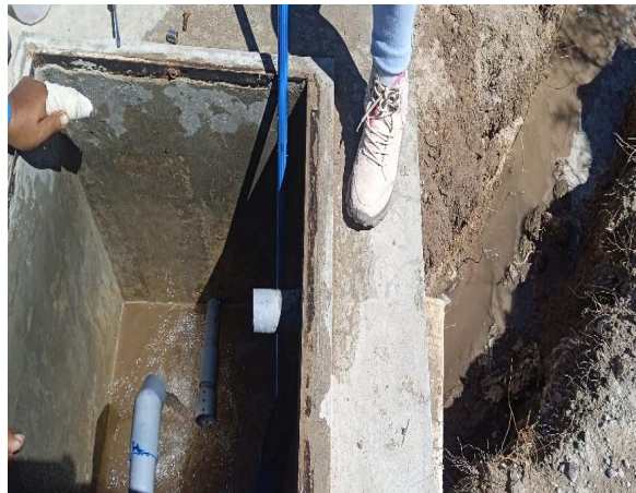
Figura 16. Limpieza en la válvula de rompe presión tipo 6 mediante purga. Fuente: Elaboración Propia
