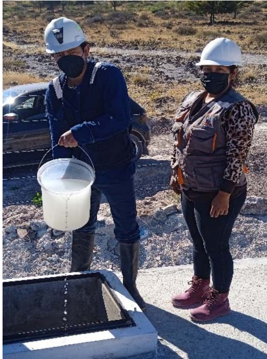
Figura 5. Depositando la solución clorada para desinfectar el reservorio. Fuente: Elaboración Propia
