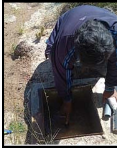
Figura 14. Reparación de unión entre la línea de conducción y la válvula de aire.
