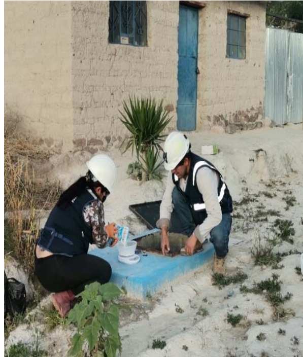
Figura 6. Pesando el hipoclorito de calcio para desinfectar la cámara rompe presión tipo 7. Fuente: Elaboración Propia
