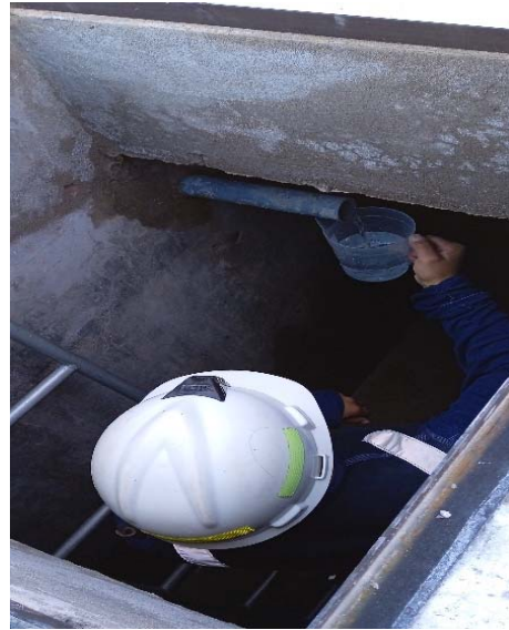
Figura 2. Verificación del caudal de entrada al reservorio. Fuente: Elaboración Propia
