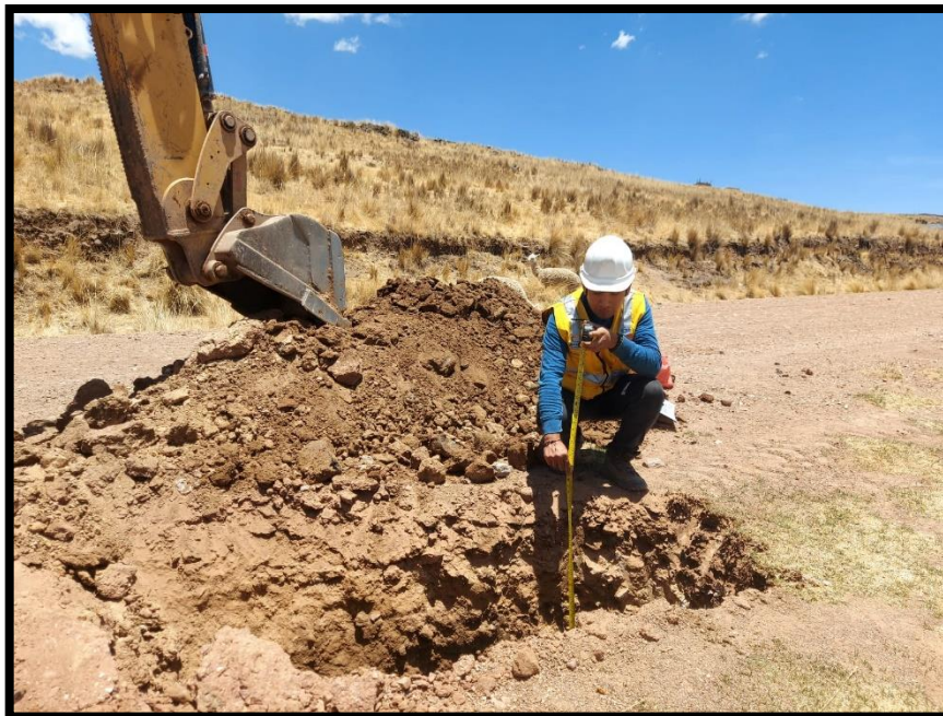
Figura 13. Excavación de calicata-1.
