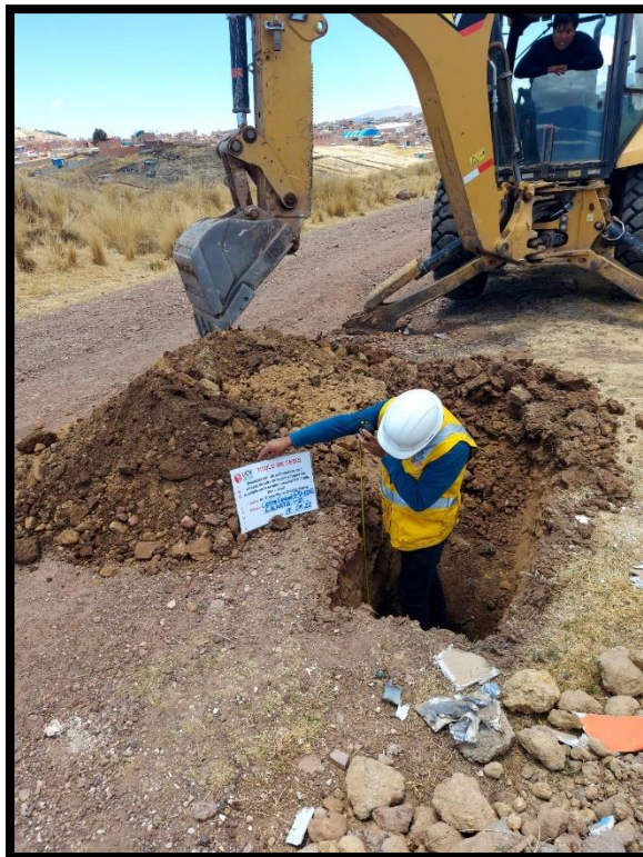
Fotografía 2. Excavación de calicata -2 en camino vecinal PU-1065.
