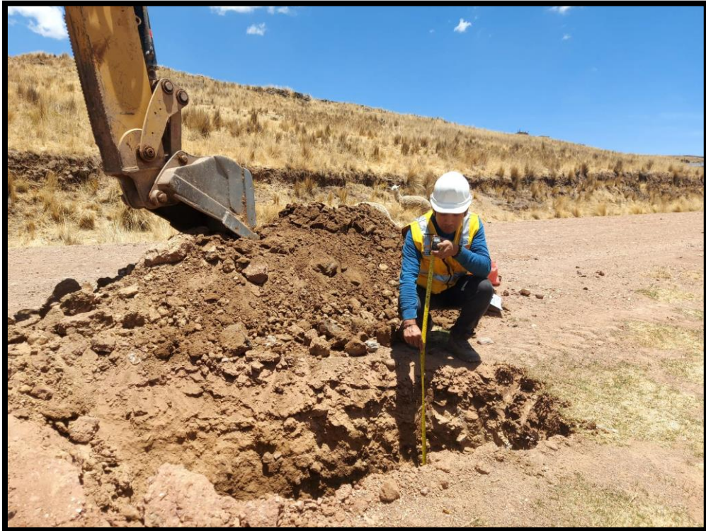
Fotografía 1. Excavación de calicata -1 en camino vecinal PU-1065.
