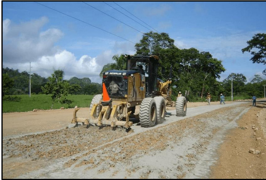
Figura 7. Mezcla de estabilizante con el suelo natural.
