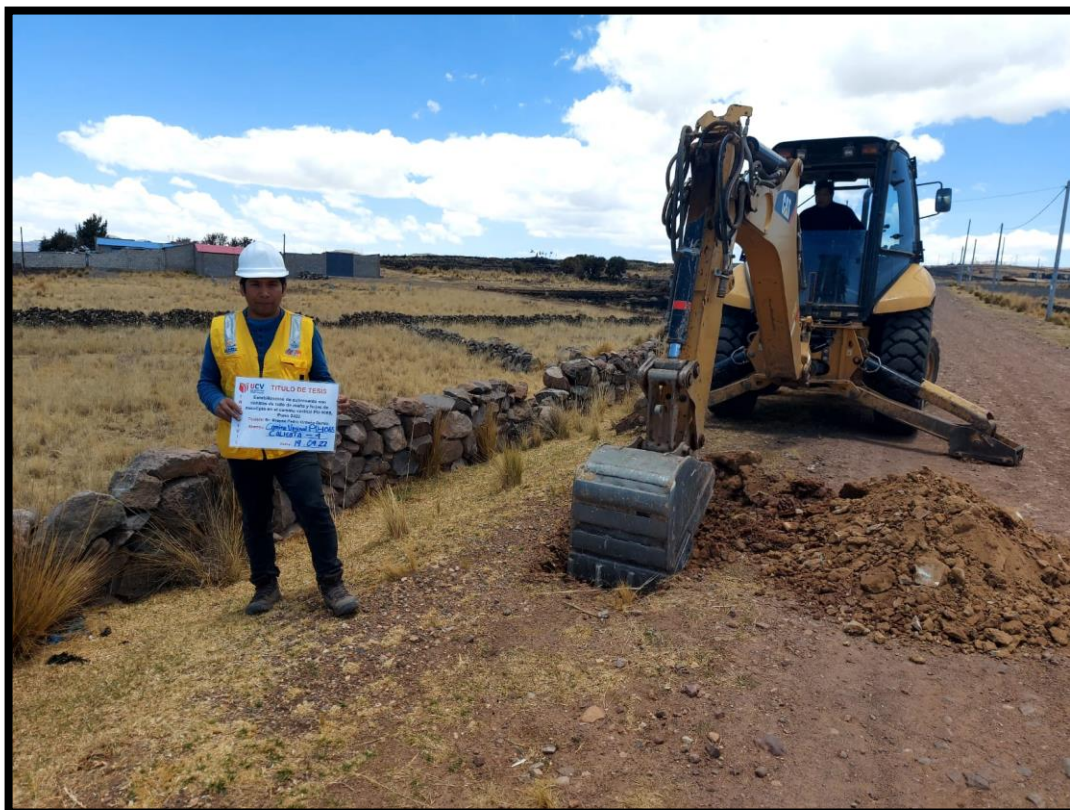
Fotografía 4. Excavación de calicata -4 en camino vecinal PU-1065.
