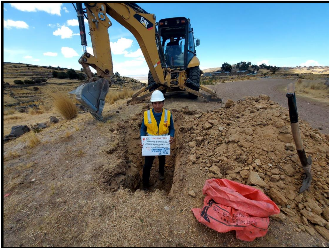
Fotografía 3. Excavación de calicata -3 en camino vecinal PU-1065.
