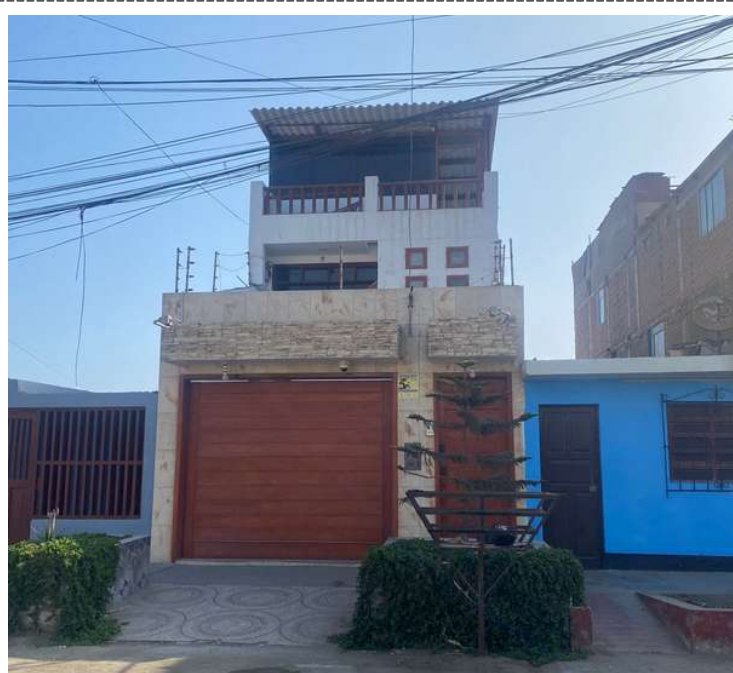
IMAGEN 1: Fachada de la vivienda multifamiliar 1
