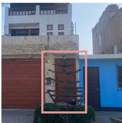
IMAGEN 5: Acceso principal al departamento
