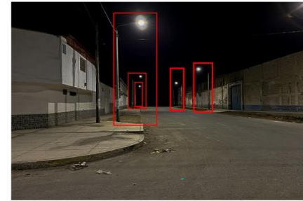
La calle 04 (Jr. Callao), una zona de fábricas, presenta cinco postes de alumbrado público.
