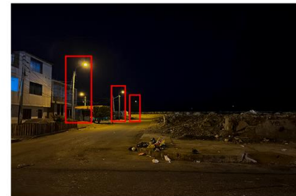
La calle 08 (Psj. Salaverry), presenta tres postes de alumbrado público.
