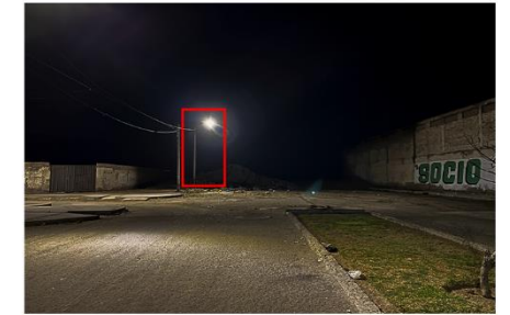
La calle 05 (Jr. San Martín), presenta un único poste de alumbrado público.
