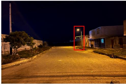
La calle 02 (Av. San Pedro), presenta dos postes de alumbrado público.
