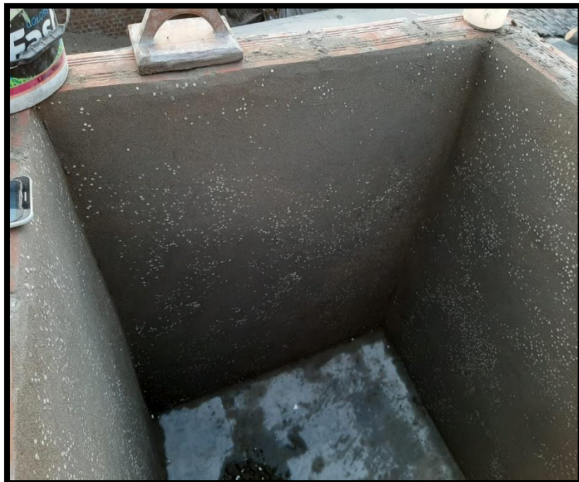
Figura 31. Tarrajeo interior de prototipo
