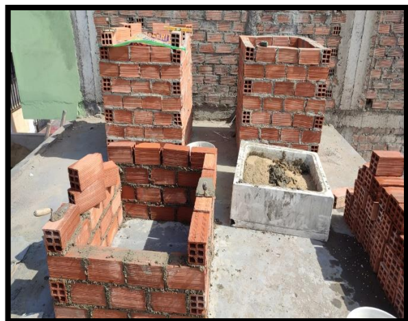
Construcción de prototipos
