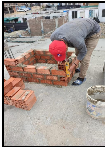
Nivelación vertical de muros
