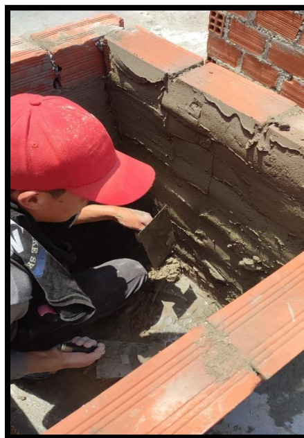
Figura 21. Tarrajeo en muros de prototipo convencional
