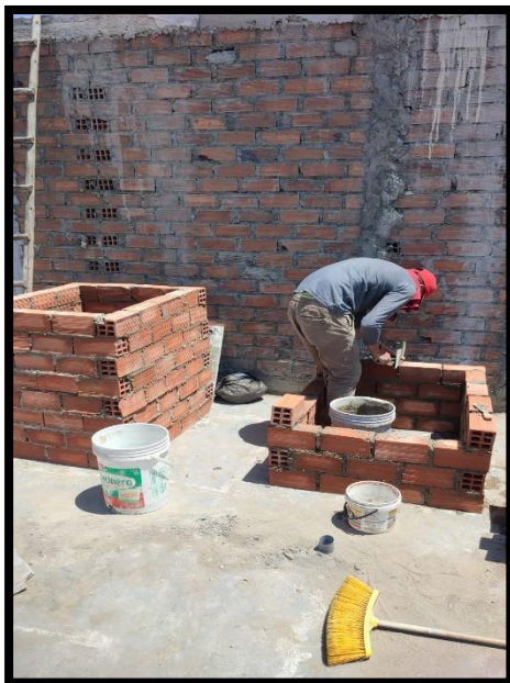
Construcción de prototipos
