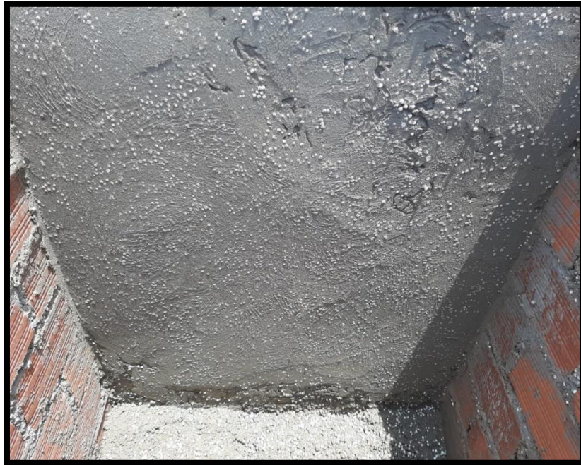
Figura 30. Relleno de imperfecciones en muro
