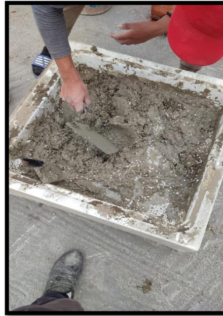
Preparación de mezcla de mortero para juntas en asentado de ladrillos
