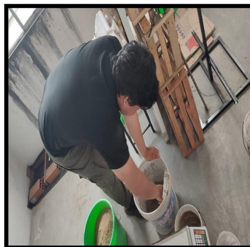
Preparación de mezcla
