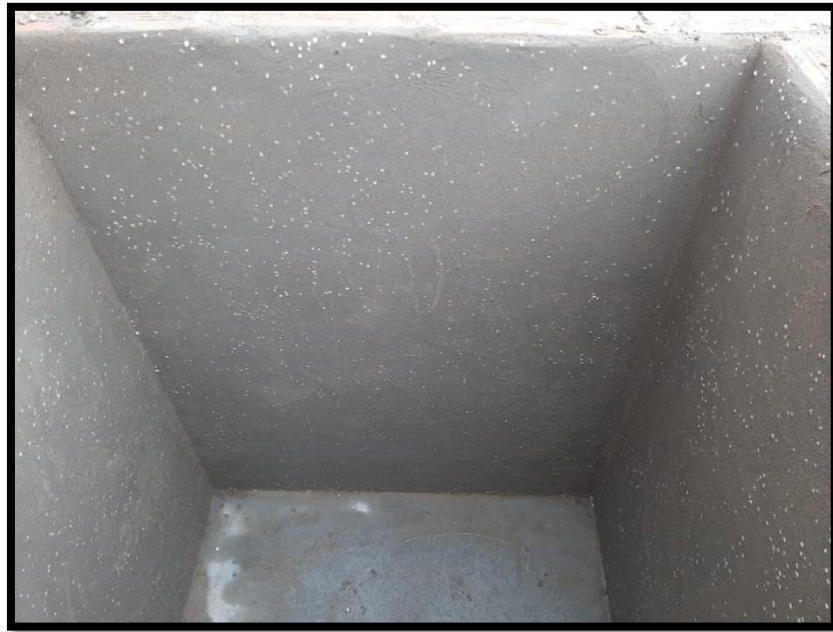
Figura 25. Tarrajeo interior de prototipo
