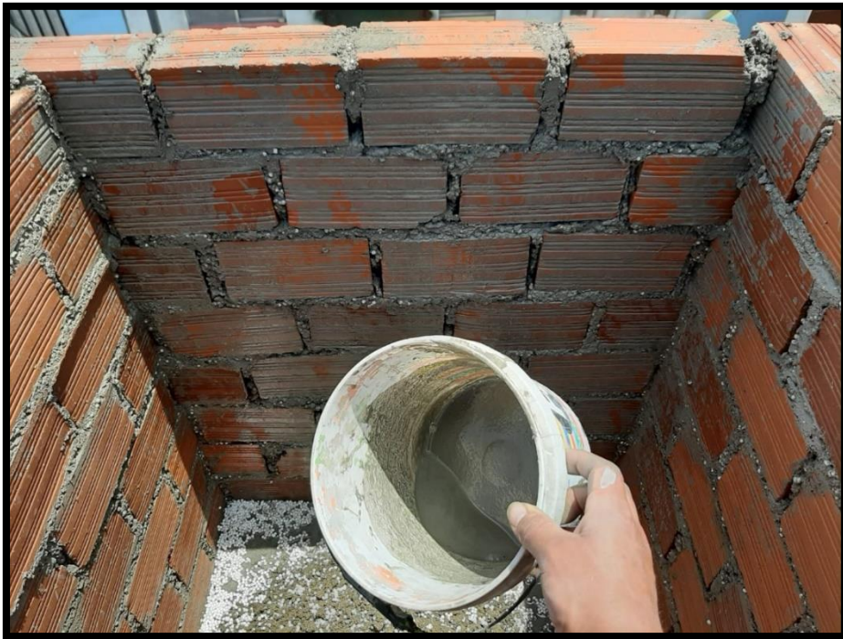
Figura 28. Rociado de agua y cemento al interior del prototipo
