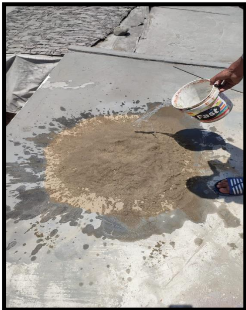
Preparación de mezcla
