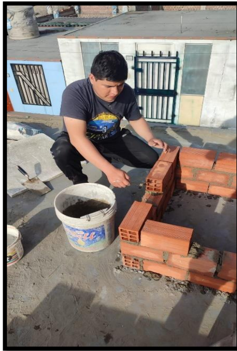
Figura 9. Asentado de ladrillos
