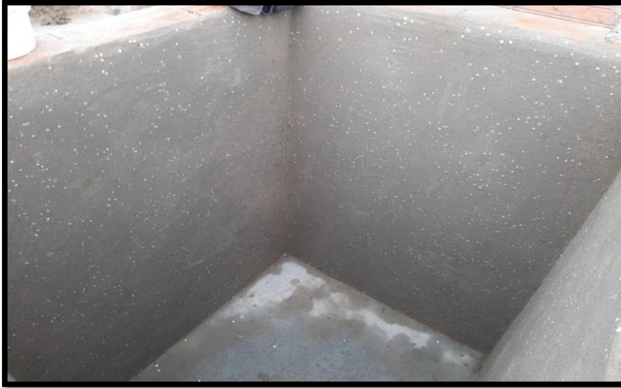
Tarrajeo interior del prototipo con 25% de perlas de eps reciclado
