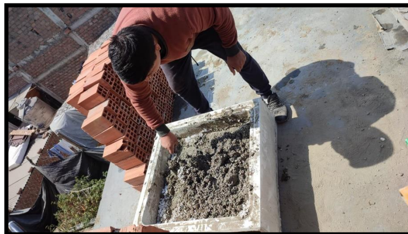
Figura 19. Diseño de mezcla de mortero de junta con 50% de perlas de eps reciclado
