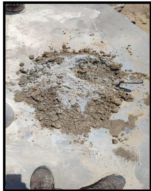
Preparación de mezcla
