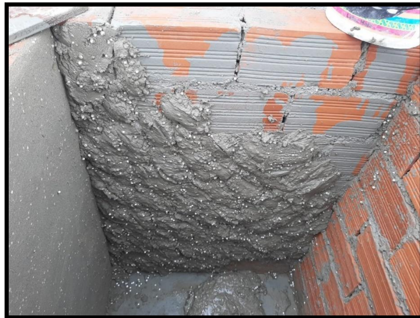
Figura 24. Pañetado de muro
