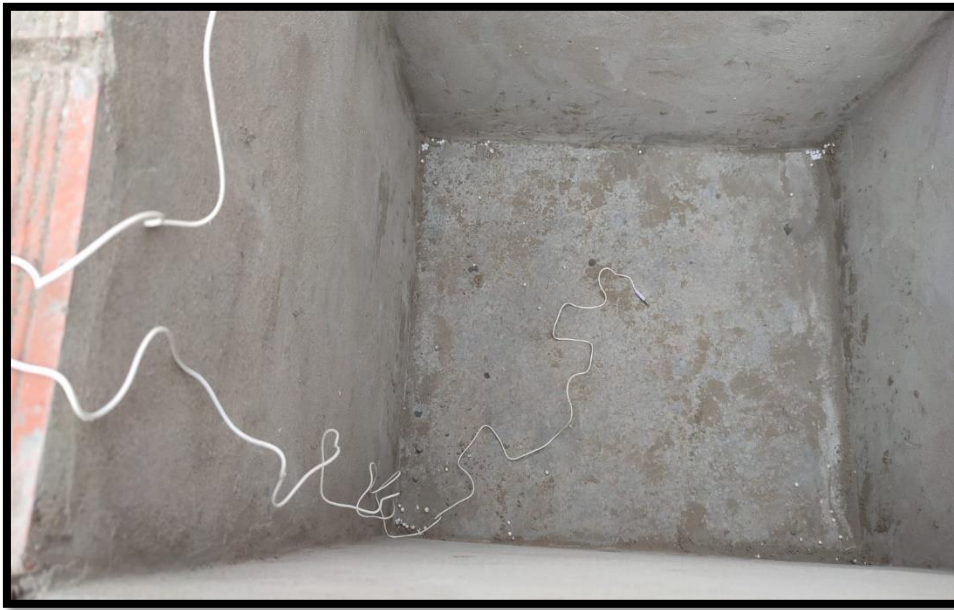
Tarrajeo interior del prototipo convencional
