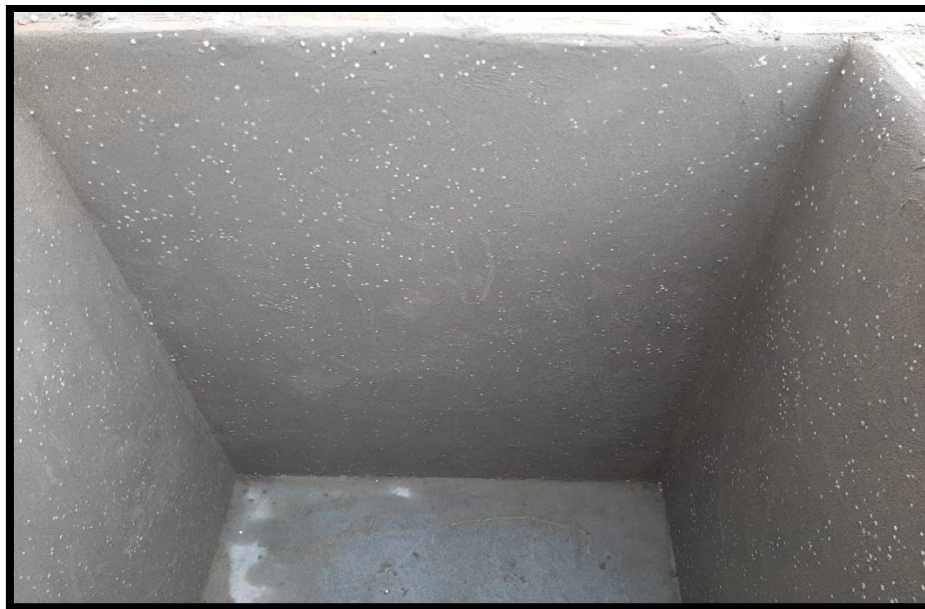
Tarrajeo interior del prototipo con 10% de perlas de eps reciclado
