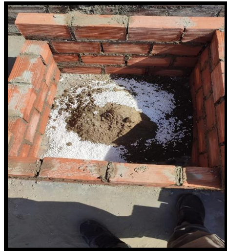
Preparación de mezcla con mortero con perlas de eps reciclado
