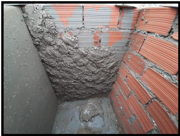
Mezcla de mortero para tarrajeo de muros con porcentajes de eps reciclado
