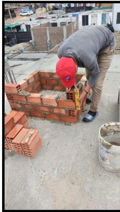
Figura 16. Nivelación vertical de muro
