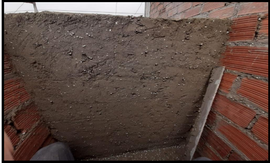
Figura 26. Regleado de muro
