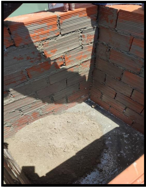
Rociado de agua con cemento previo al tarrajeo de muros
