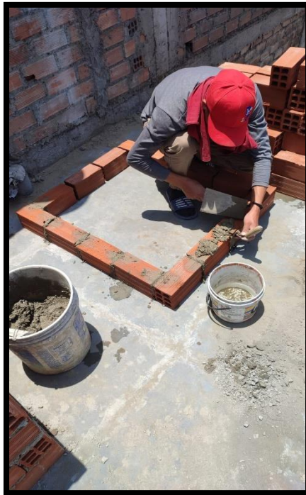
Figura 12. Asentado de ladrillo con mortero con 10% de perlas de eps
