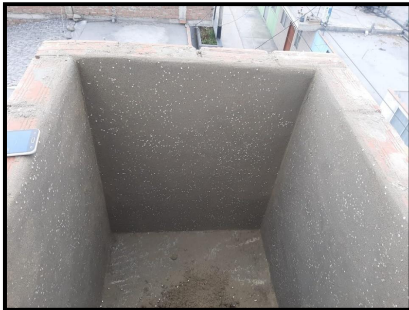
Figura 27. Tarrajeo interior de prototipo
