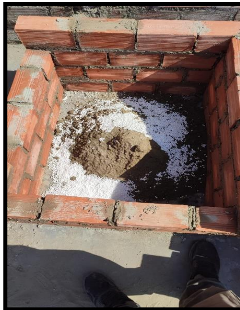
Figura 5. Mezcla de mortero con porcentajes de perlas de eps de junta para asentado de ladrillo
