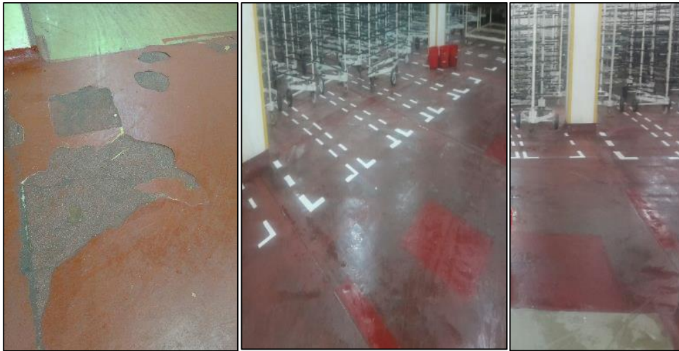
Figura 74. El antes y después de la reparación de pisos en sala de fermentación
