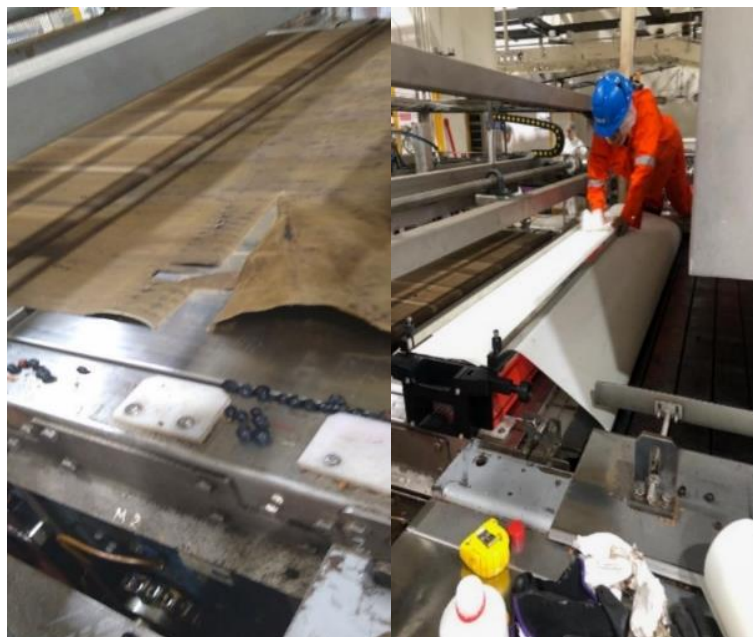
Figura 71. Cambio de faja transportadora de salida horno el antes y después del cambio.
