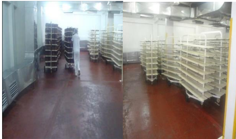
Figura 66. Sala de fermentación pisos sin pintar
