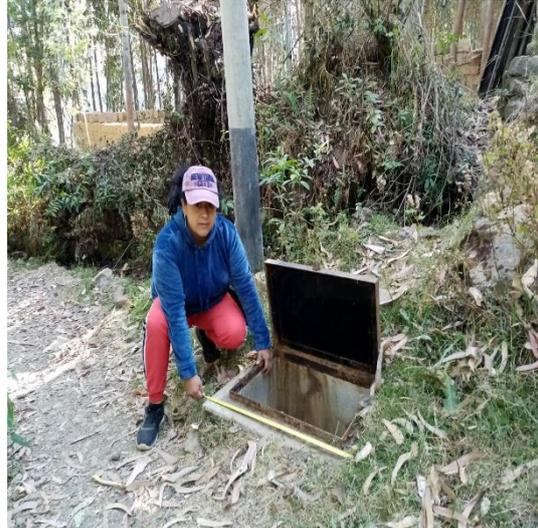
Figura 09: Se realiza, la toma de dimensiones de la estructura, verificación del estado físico de la válvula de purga que Cuenta cada pueblo
