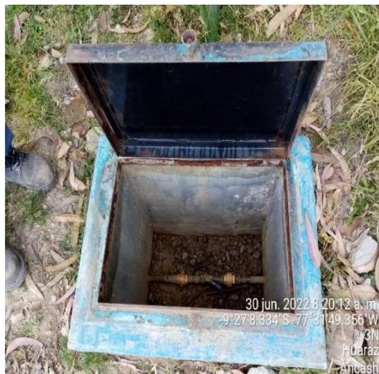
Figura 10: Se realiza, la toma de dimensiones de la estructura, verificación del estado físico de la llave de control.
