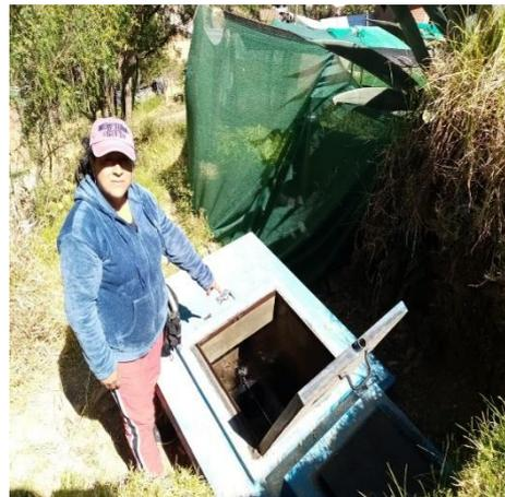
Figura 07: Se realiza la verificación del estado de funcionamiento de las cámaras rompe presión así mismo la toma de dimensiones y observación del tipo de tubería de dichas cámaras.
