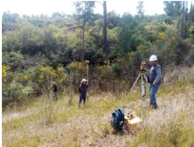
Figura 41. Levantamiento topográfico para diseño de línea de conducción.
