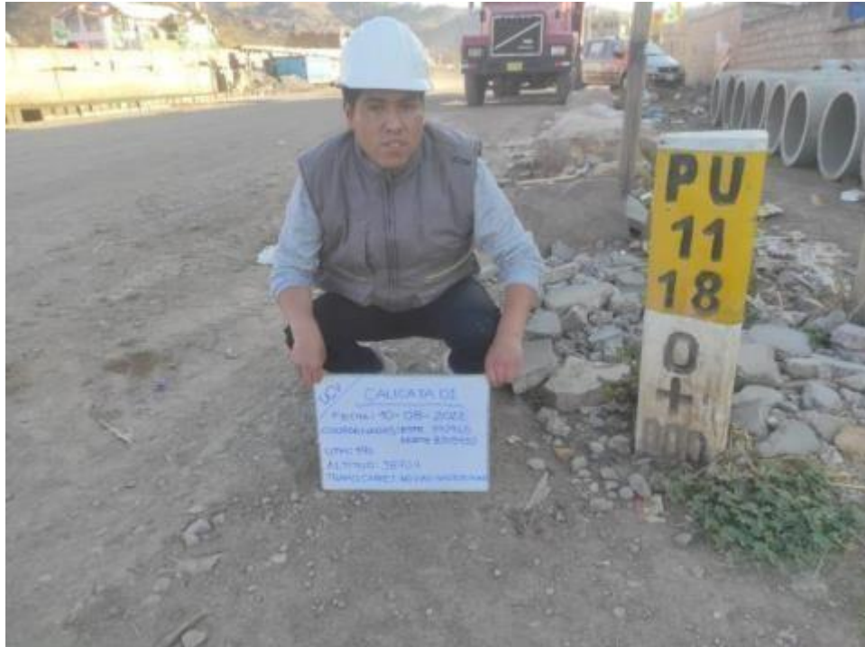
FOTO 1: Tramo de la carretera km 0+000 (Calicata N° 01)
