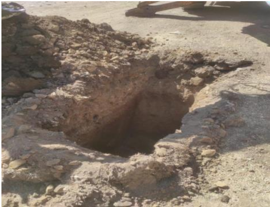
FOTO 2: Tramo de la carretera km 1+000 (Calicata N° 02).
