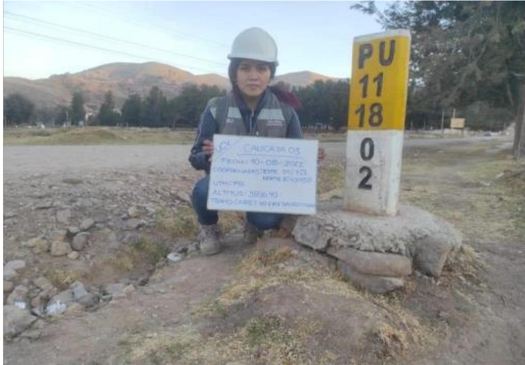
FOTO 3: Tramo de la carretera km 1+000 (Calicata N° 03).
