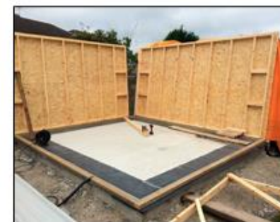
Aplicación del tablero OSB
