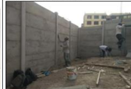
Colocación de cerco tipo placa
