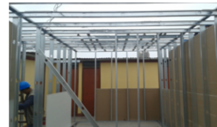
Colocación de la base metálica
