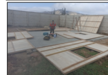
Colocación de panel machimbrado
