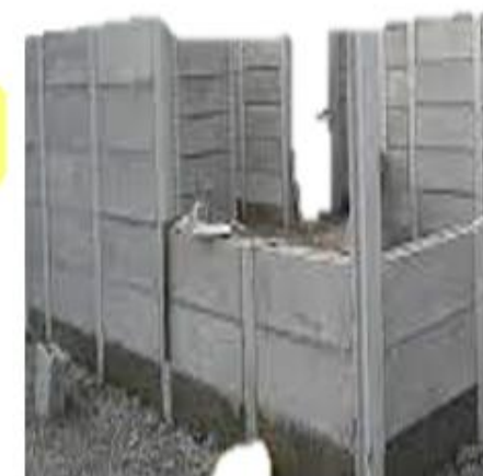
Muro de placa prefabricada
