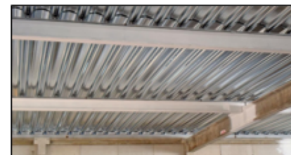
Vista de techos de calamina
