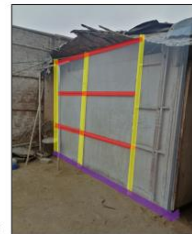
Muro de Triplay cara Exterior
