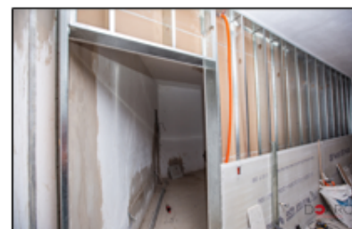
Proceso constructivo de fibrocemento
