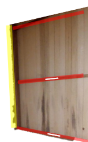
Muro de Triplay cara Exterior
