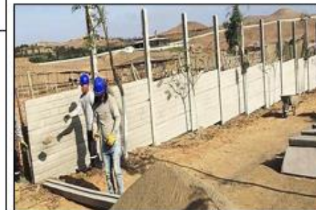
Colocación de cerco tipo placa
