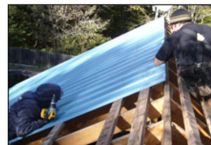
Colocación de calamina
