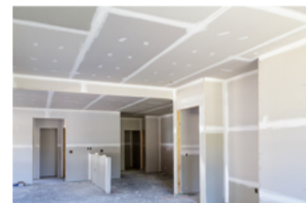
Colocación de las placas de yeso
