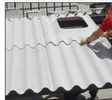
Colocación de Eternit
