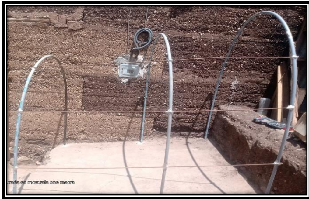
Figura 1. Se realizó el armazón del fitotoldo.
