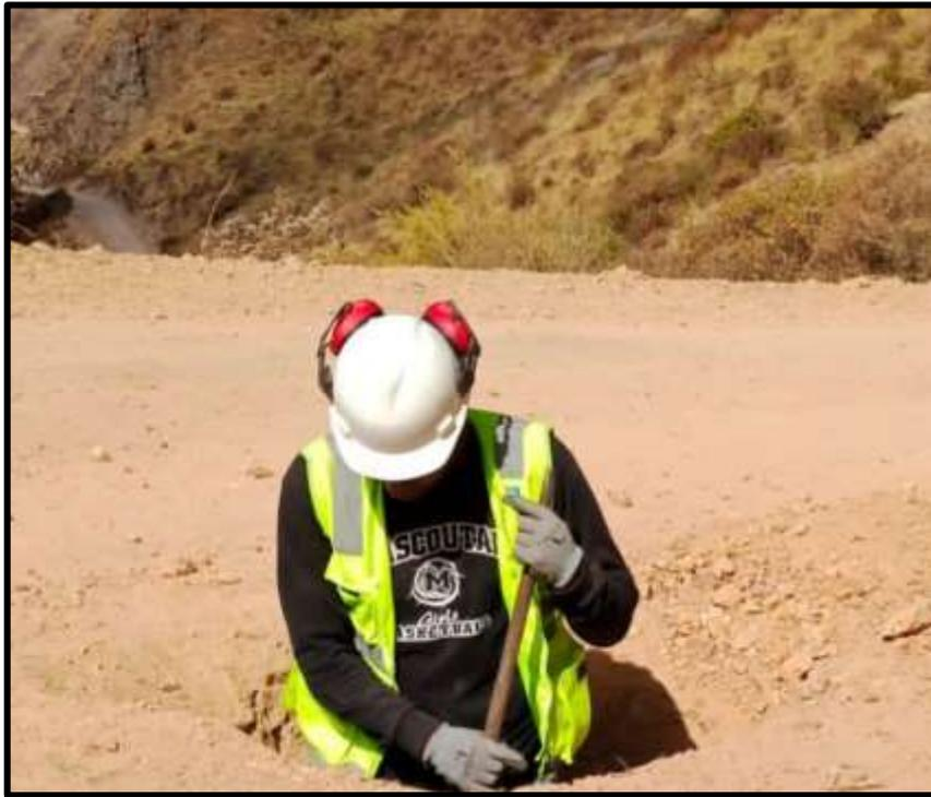
*Figura 12.* Calicata, proceso de excavación 02.
