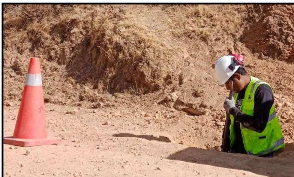
*Figura 11.* Calicata, proceso de excavación 01.
