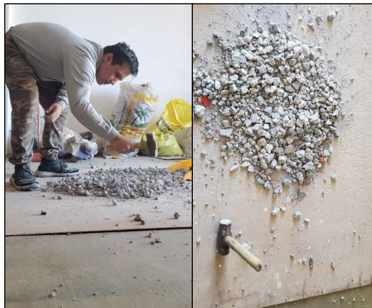
Figura 8: Trituración y selección de agregado reciclado.
