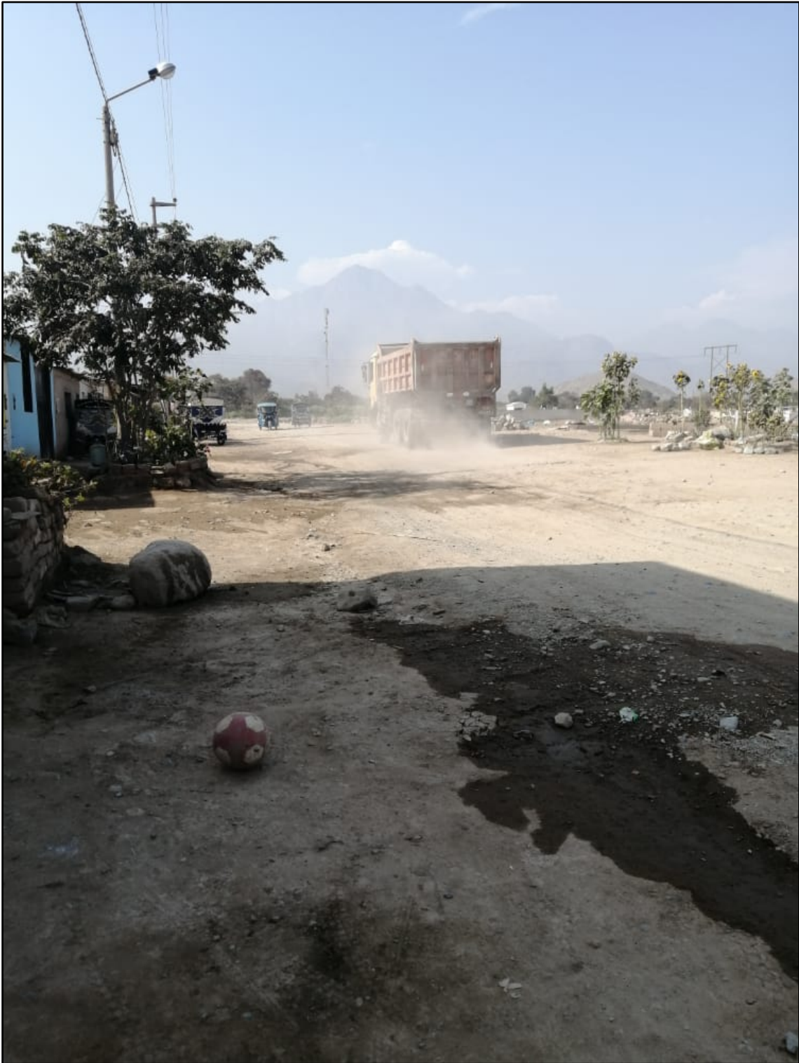
Figura 17. Vía en mal estado
