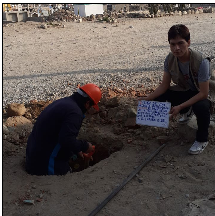
Figura 21. Excavación de para estudio de suelos
