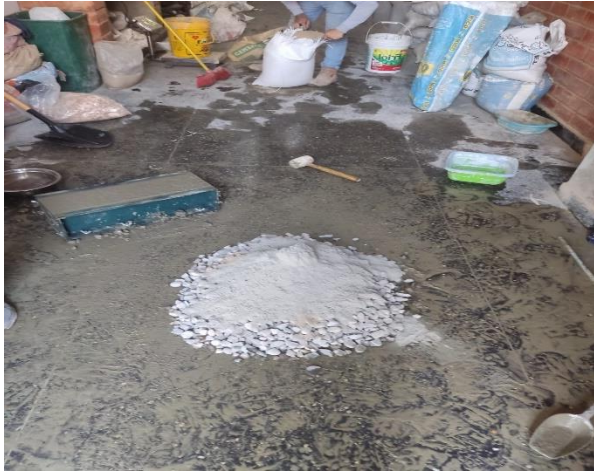
Preparación de mezcla de material
