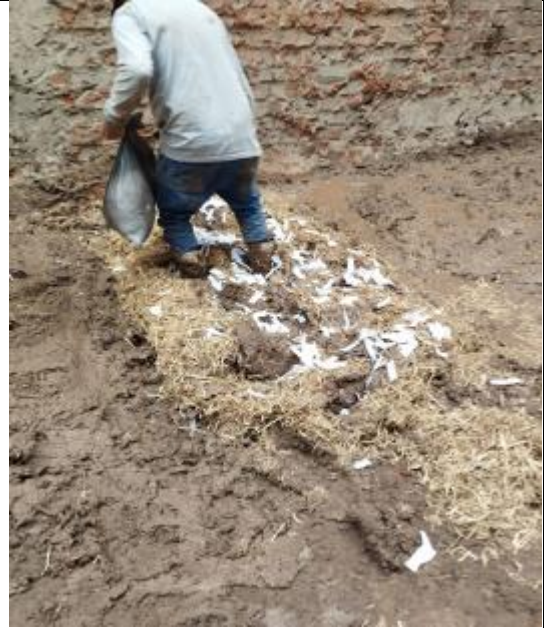
6. Mezclado de la tierra, paja y polipropileno.
