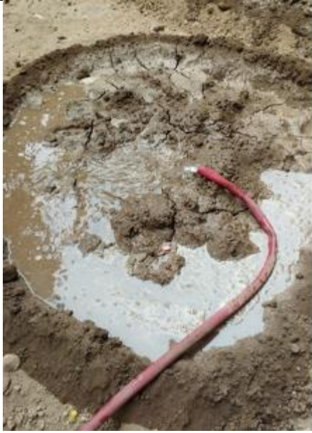
5. Homogenizando la tierra para una mejor trabajabilidad.
