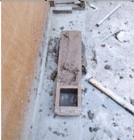
7. Moldes y colocación del barro para tener los bloques.
