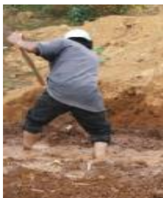
Figura 9. Mezclado de agua con tierra para batir
