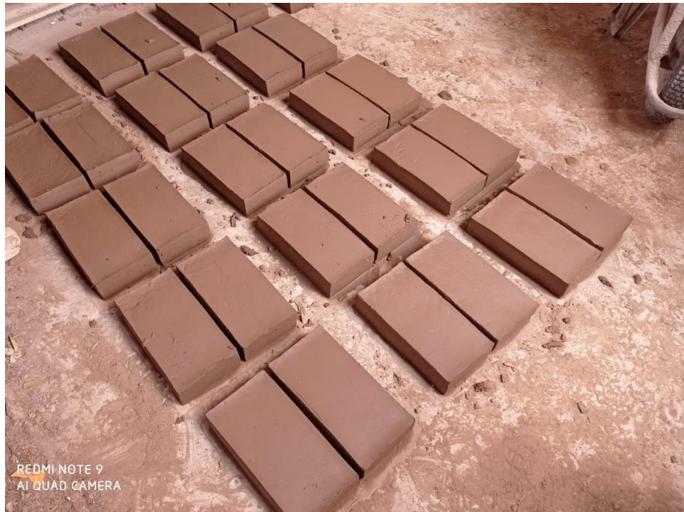
Figura 39. Se tiene los adobes ya moldeados en un lugar adecuado para el secado.
