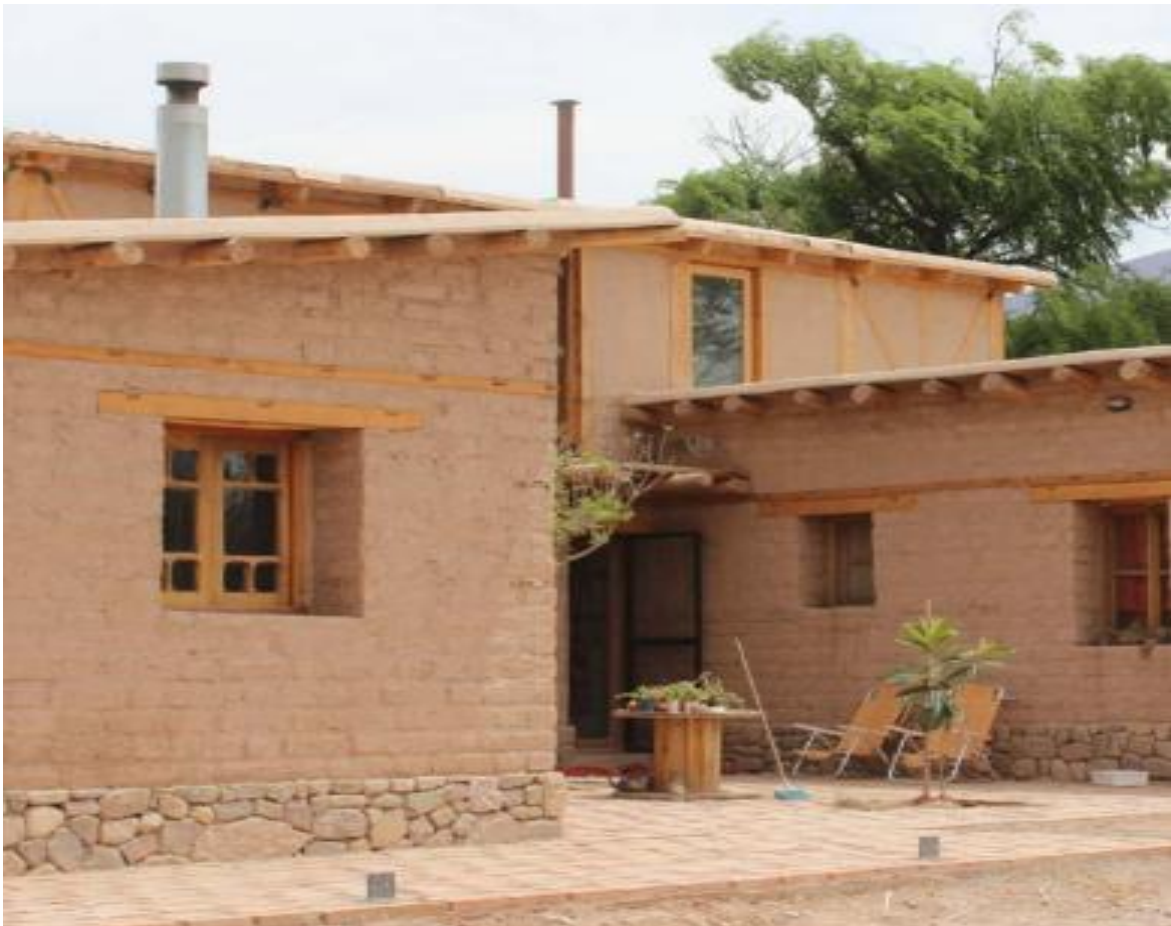
Figura 4. Diseño y construcción de una vivienda familiar realizada a partir de adobes. Obtenido de (Rotondaro et al. , 2018, p. 19).
