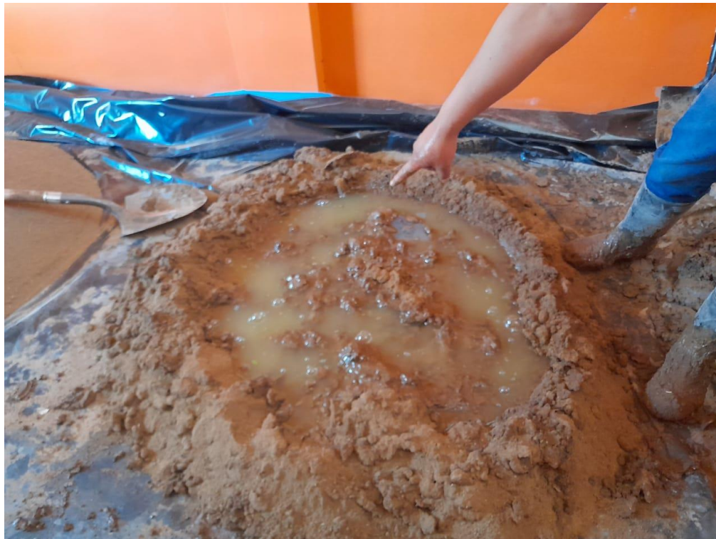
Figura 34. Mezclado de la tierra con baba de nopal según dosificación.
