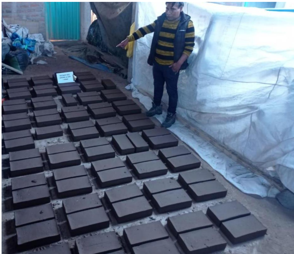
Figura 40. Se tiene los adobes protegidos del sol para el secado adecuado.
