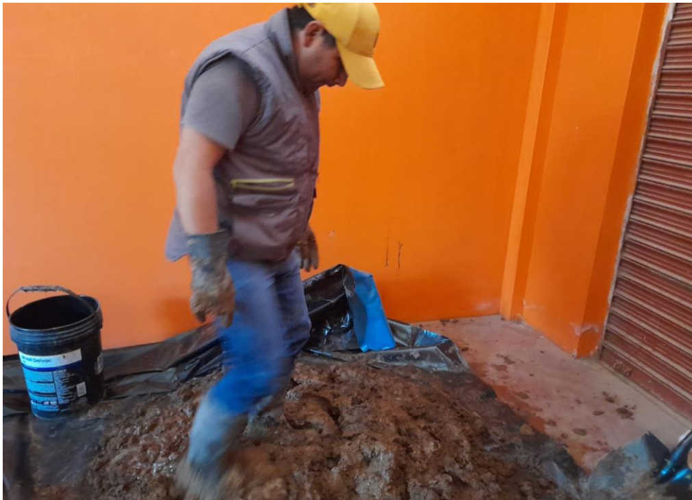
Figura 36. Se procede a mezclar el barro para proseguir con el dormido.
