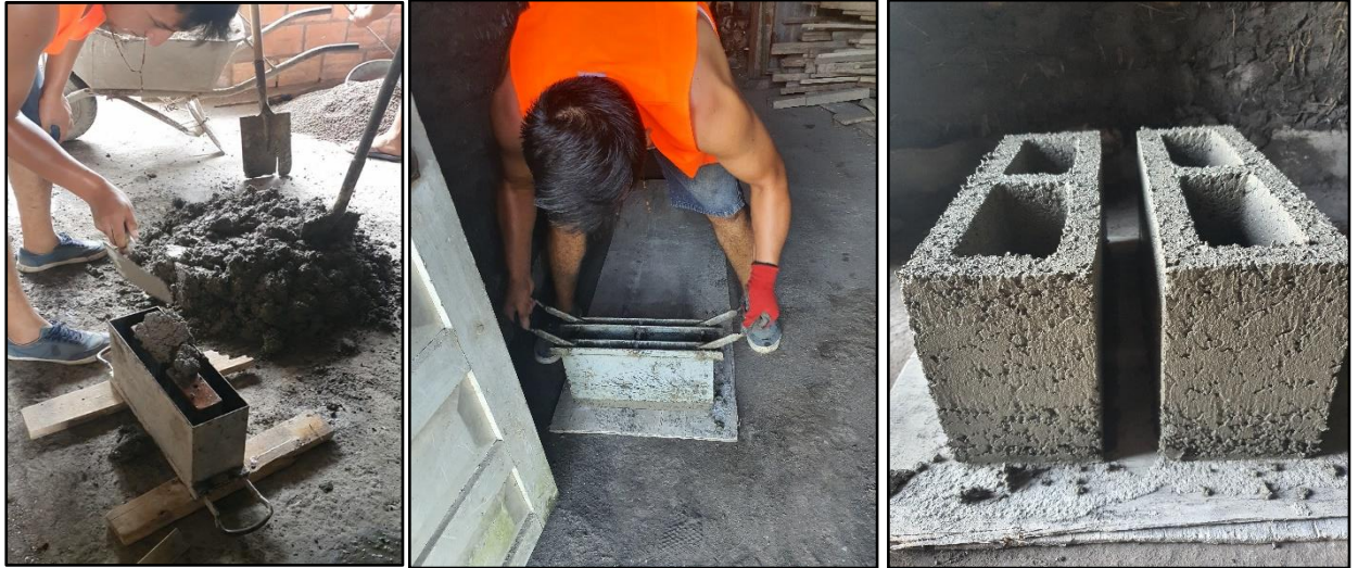
Figura 3: Elaboración de los bloques de concreto dos huecos
