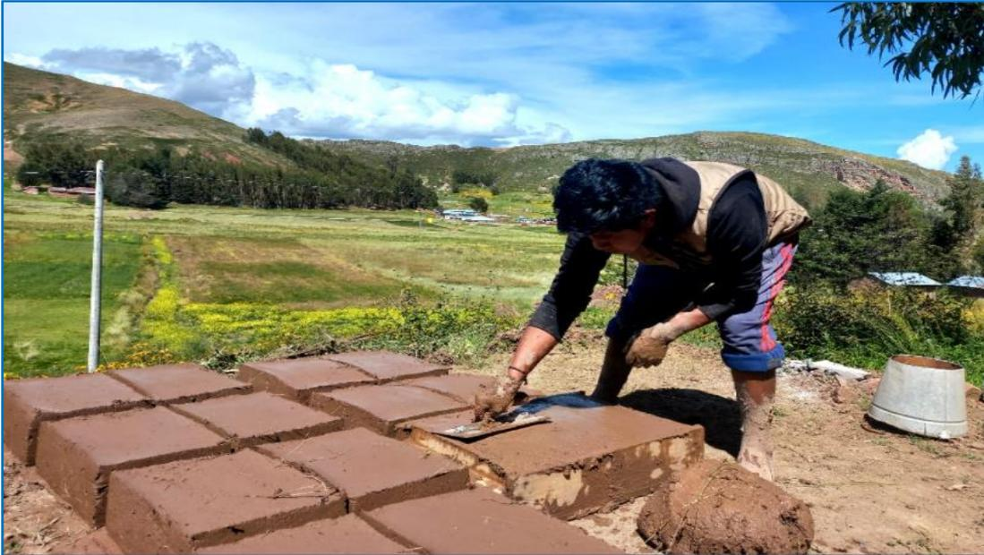
**FOTO N° 9:** Enrazado de la mezcla para adobe en el molde
