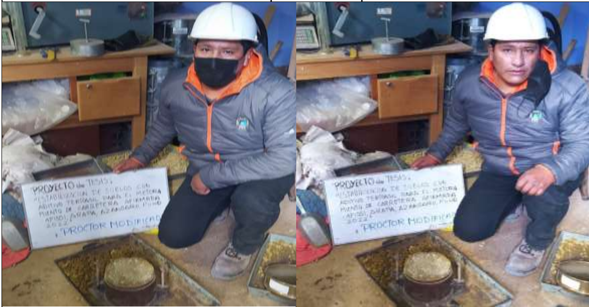
Foto 13 ensayo proctor modificado
