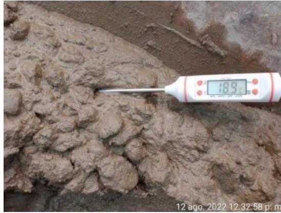
Figura 26: medición de temperatura de concreto
