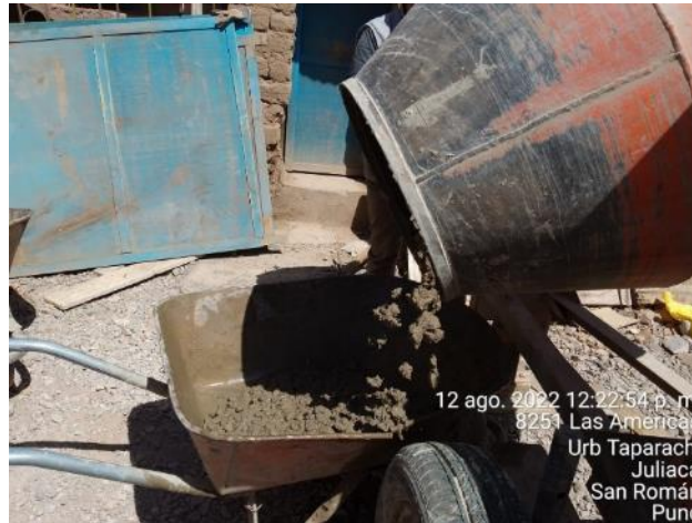
Fotografía 10: mesclado del concreto en la mezcladora
