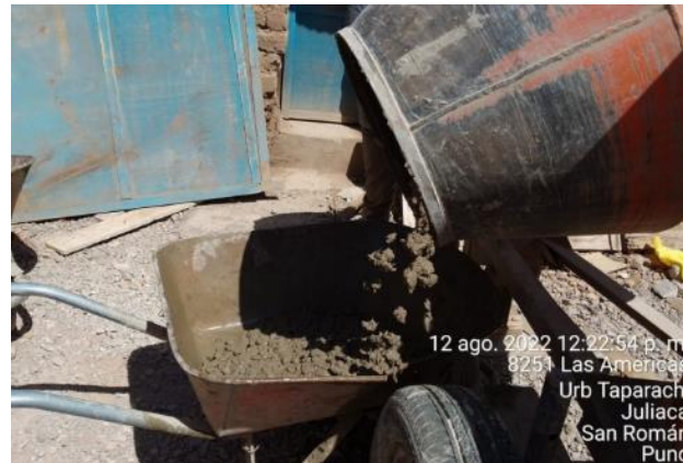
Figura 18:mezclado de concreto
