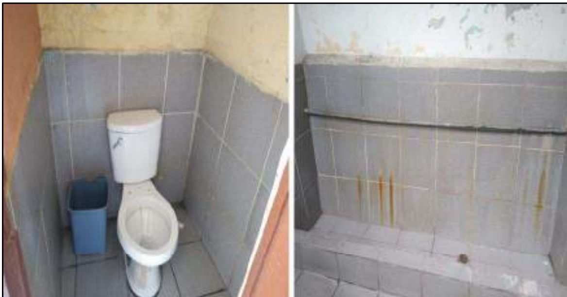
Figura 17. Vista interior de los baños de la infraestructura actual de la DREA
