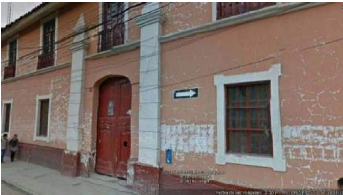
Figura 9. Fachada de la infraestructura actual de la DREA.
