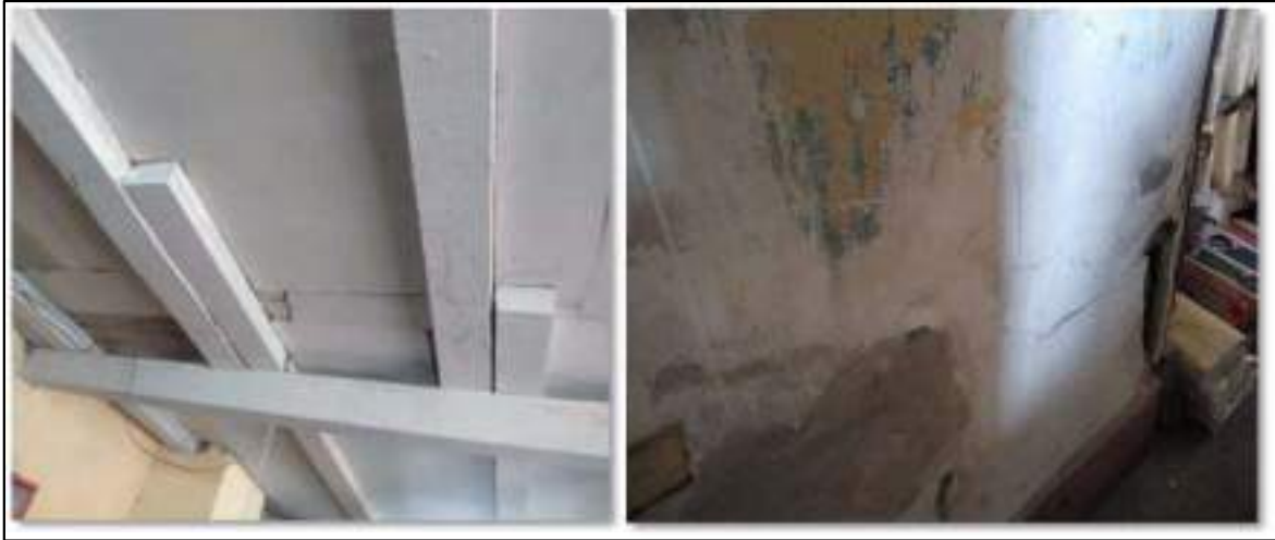
Figura 14. Vista interior de los techos de la infraestructura actual de la DREA
