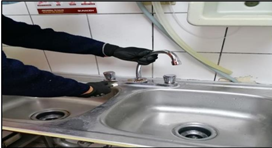
Figura 9. Cambio de accesorios (Después) Fuente: elaboración propia.
