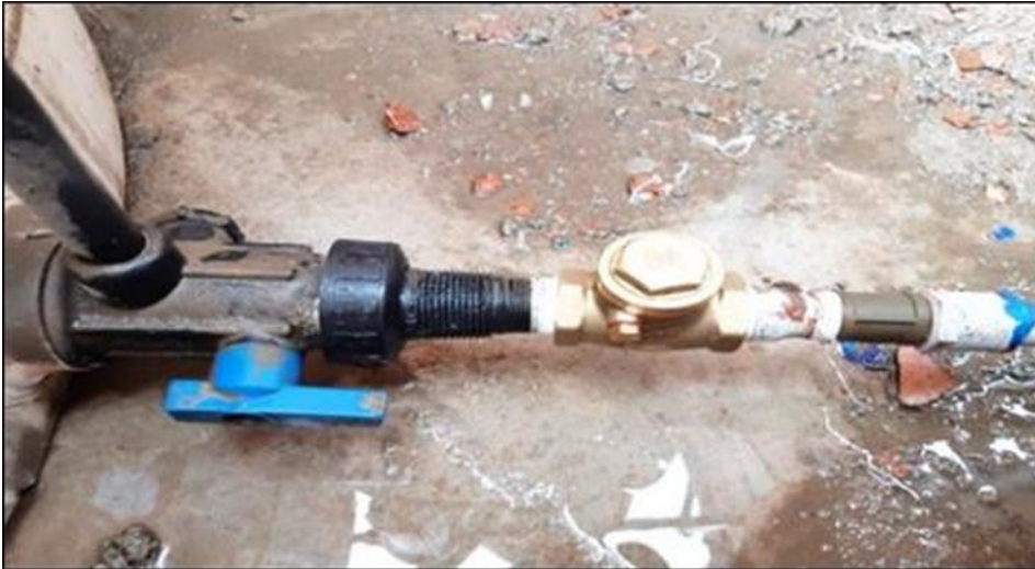
Figura 7. Cambio de Check de retorno (Después) Fuente: elaboración propia
