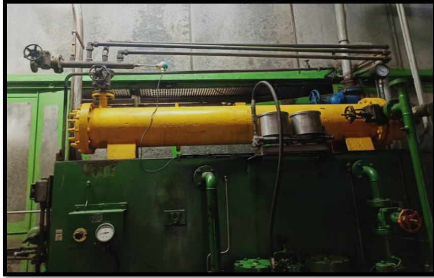
Imagen 16: Ramificaciones del sistema centralizado de lubricación
