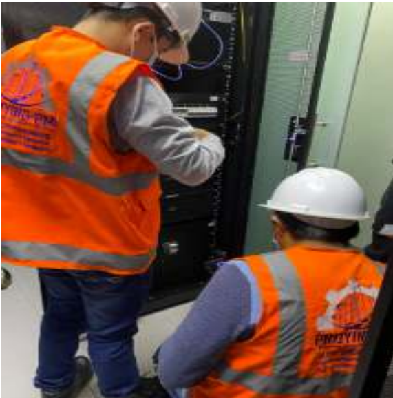
VISITA TÉCNICA EN LAS INSTALACIONES DE LA UNIVERSIDAD CONTINENTAL DE HUANCAYO
