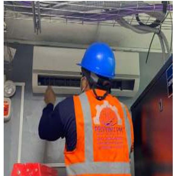
VISITA TÉCNICA EN LAS INSTALACIONES DE LA UNIVERSIDAD CONTINENTAL DE AREQUIPA
