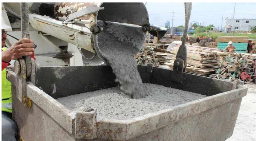
Figura 1: Concreto en obra
