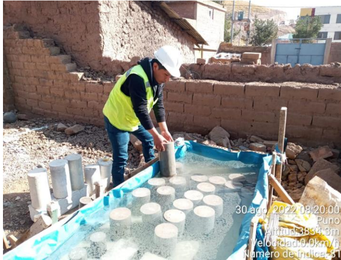
Fotografía N°40: extracción de muestras para ensayos de rotura a los 28 días
