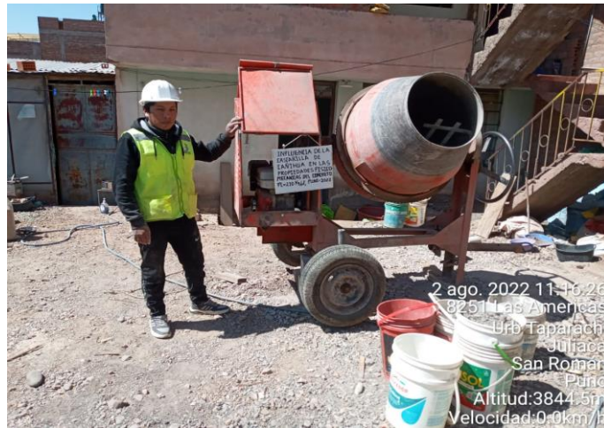
Fotografía N°13: preparación de mezcla
