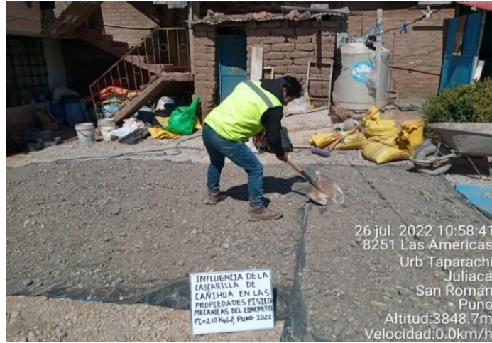
Fotografía N°1:Secado de agregados
