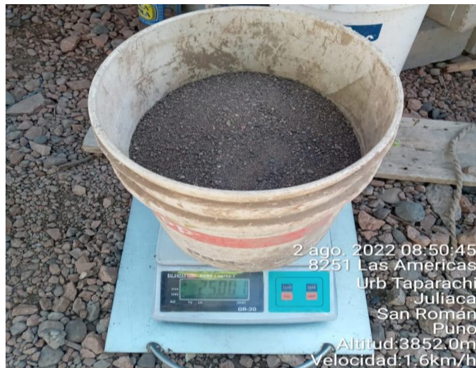
Fotografía N°11: Pesado de agregados para la mezcla
