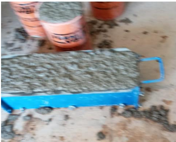
Fotografía N°18: vaciado de viga
