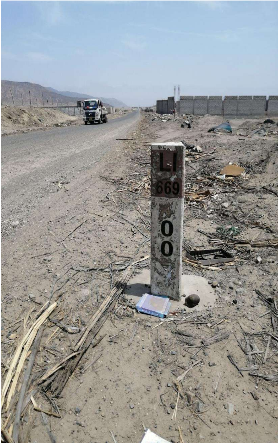
Figura 48: Identificación de la progresiva 00+00
