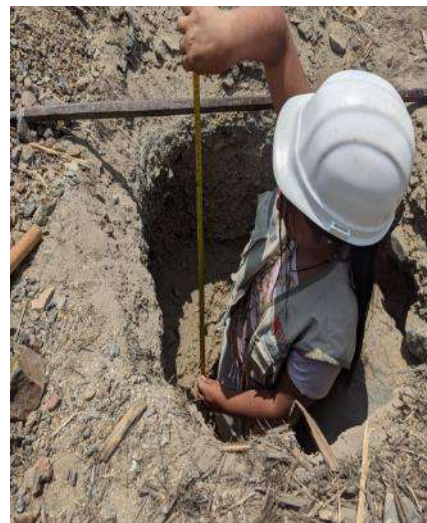
Figura 9: Toma de medida de la profundidad de la calicata
