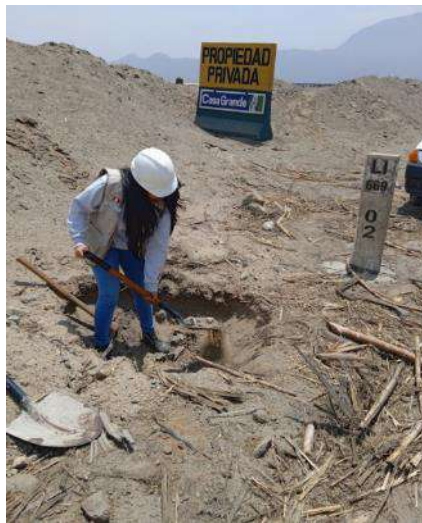
Figura 8: Proceso de excavación para calicatas
