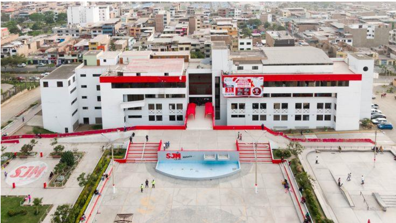
Figura 8 Fachada de la institución pública Municipal
