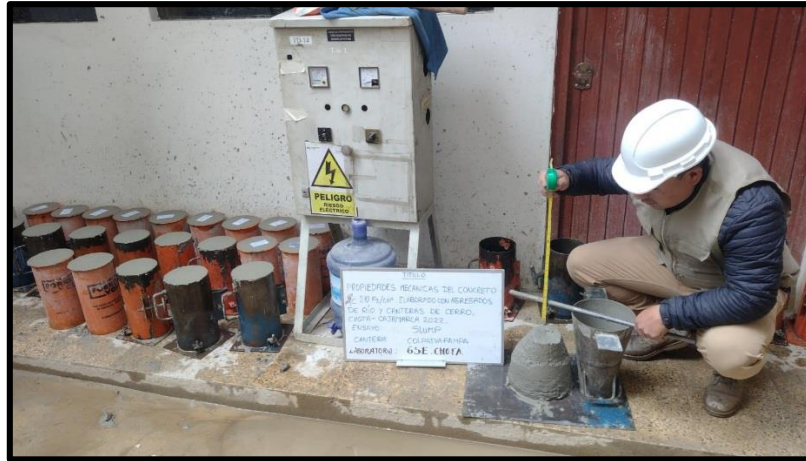
Figura 8. Ensayo de Slump
