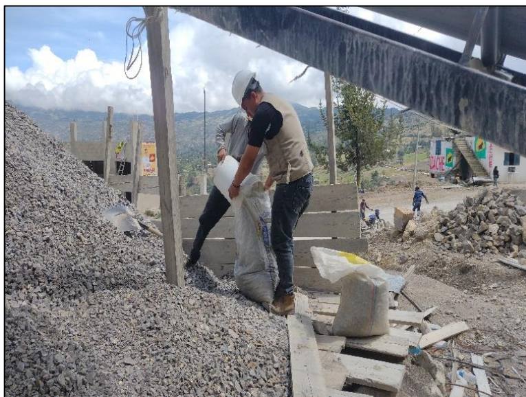
Fotografía 2: Extracción de agregados. Cantera El Gavilán
