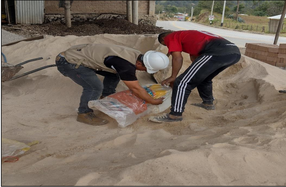
Fotografía 5: Extracción de agregado fino. Cantera Conchán
