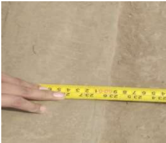
Fotografía 3: Ancho de la Av. Angamos
