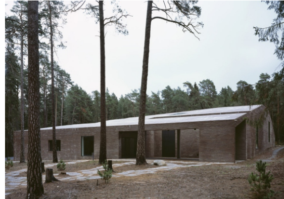
Vista de lateral del crematorio
