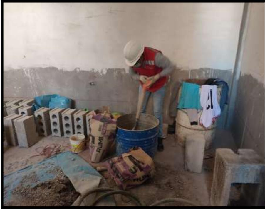
Fotografía 16: Mezclado de materiales para la elaboración de bloques de concreto
