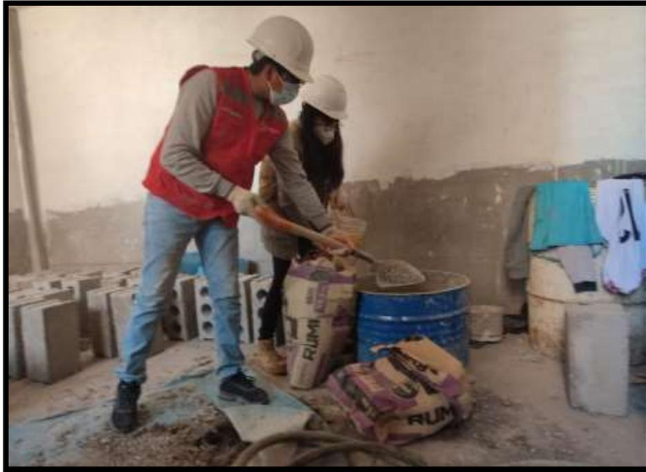
Fotografía 14: dosificación de materiales para la elaboración de bloques de concreto
