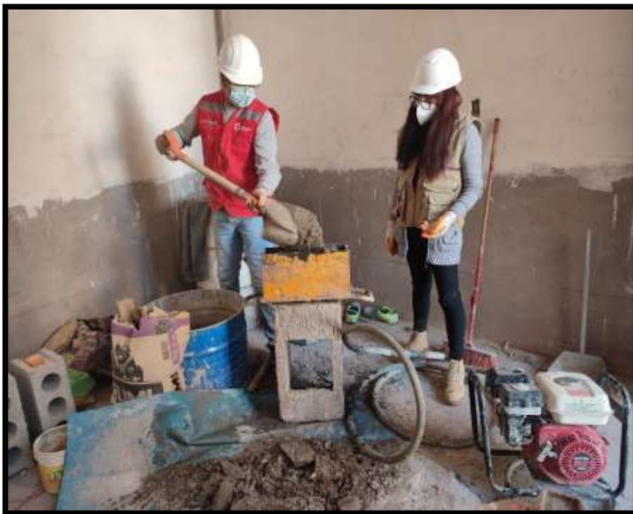
Fotografía 17: Moldeo de bloques de concreto
