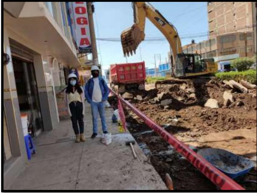
Fotografía 01: Recolección de concreto reciclado proveniente de la demolición de la carpeta de rodadura de un pavimento rígido
