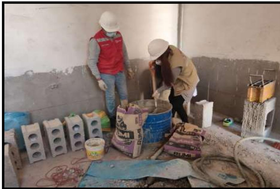
Fotografía 15: Mezclado de materiales para la elaboración de bloques de concreto
