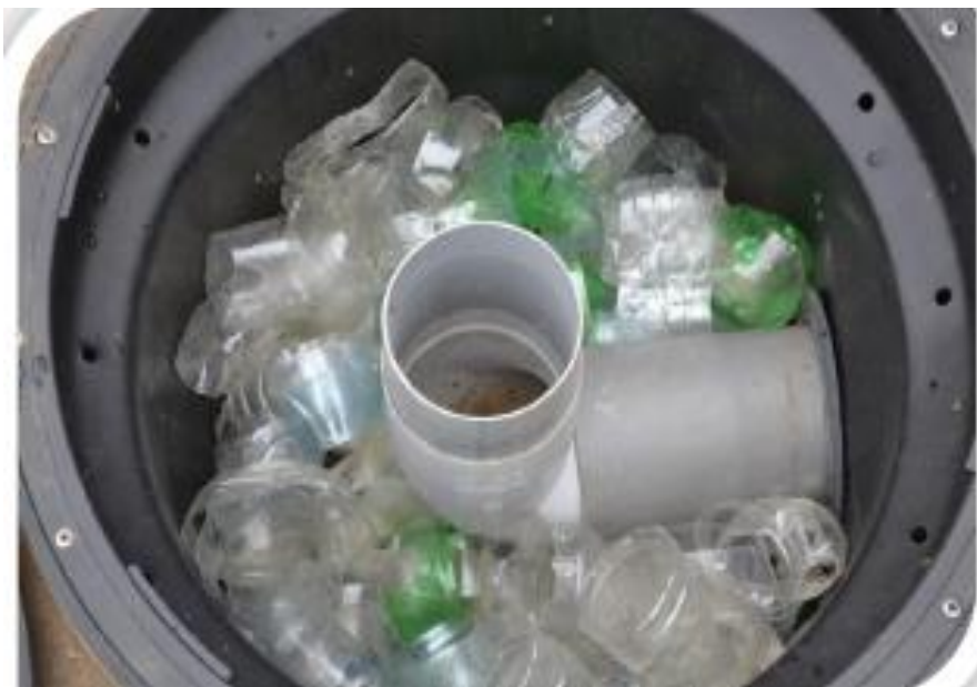
Foto. 01 Biodigestor parte Interna
