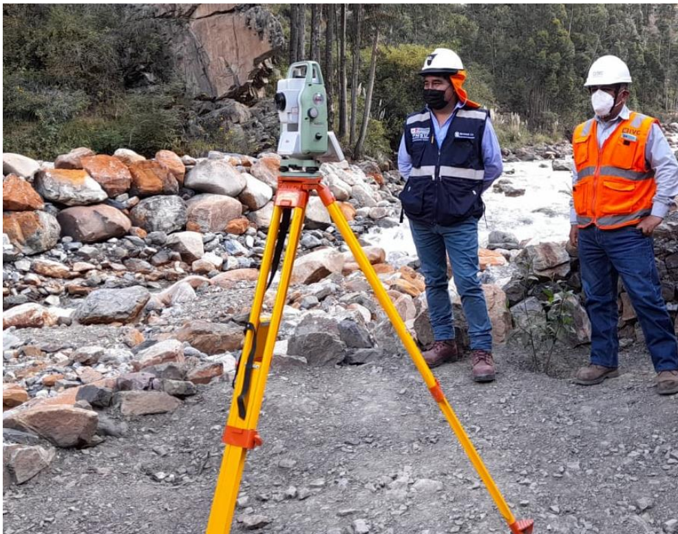
Foto 04 - Levantamiento topográfico en la progresiva 0+1200 de la línea de conducción.
