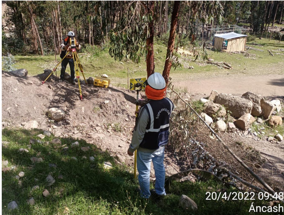
Foto 03 - Levantamiento topográfico en la progresiva 0+0800 de la línea de conducción.
