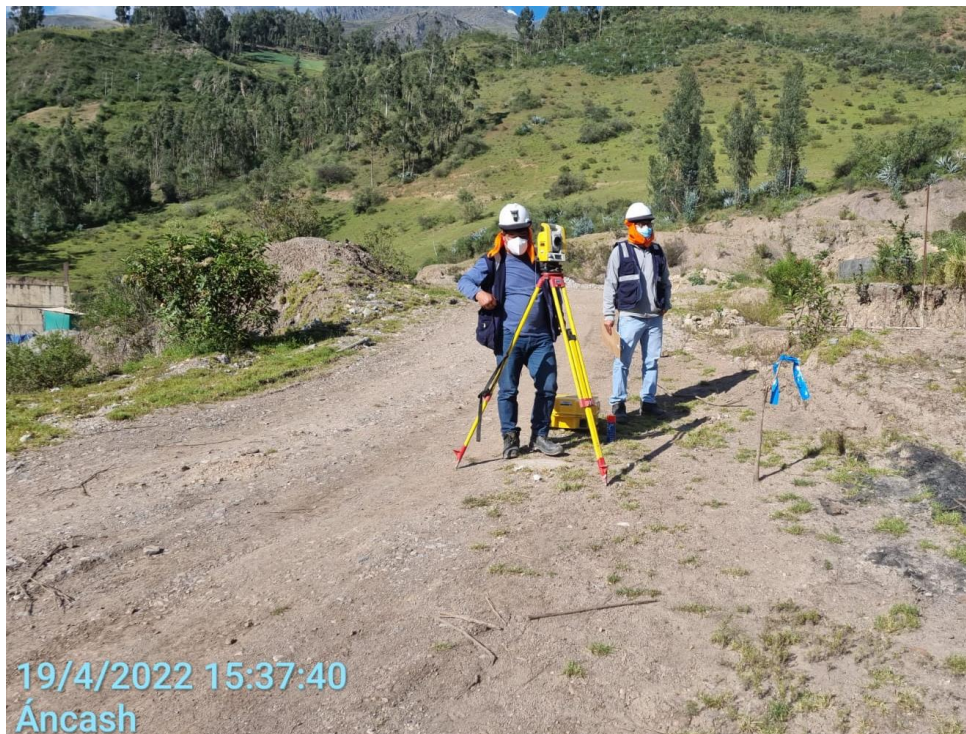
Foto 02 - Levantamiento topográfico en la progresiva 0+0500 de la línea de conducción.
