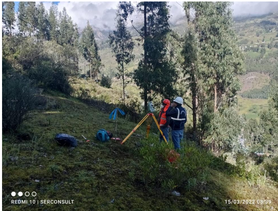
Foto 01 - Levantamiento topográfico en la progresiva 0+0200 de la línea de conducción.
