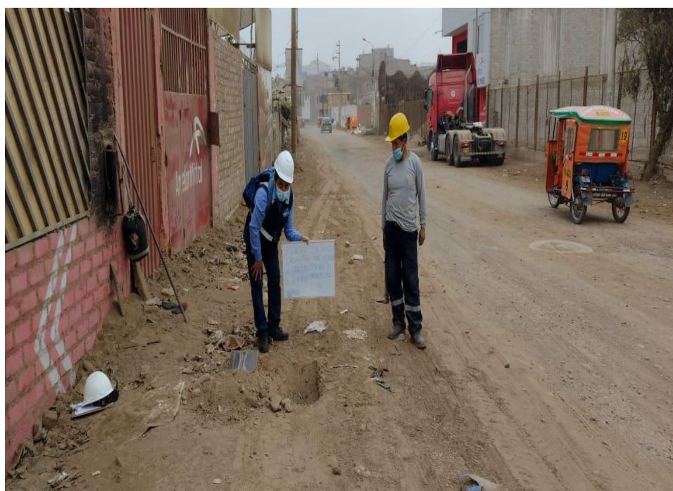
Figura 22. Medida para excavación de la Calicata 01
