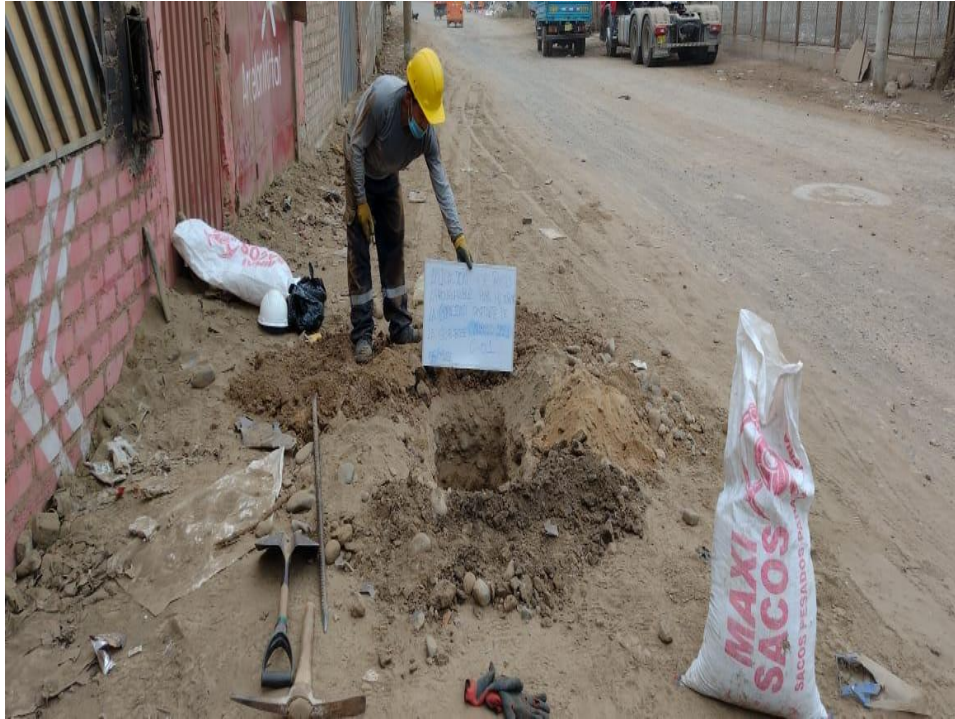
Figura 23. Excavación de Calicata 01
