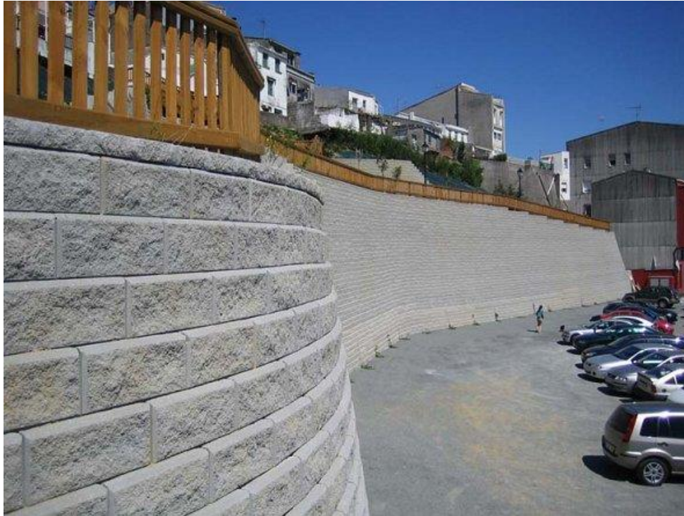
Figura 2. Acabado estético del uso de bloques de concreto prefabricado.
