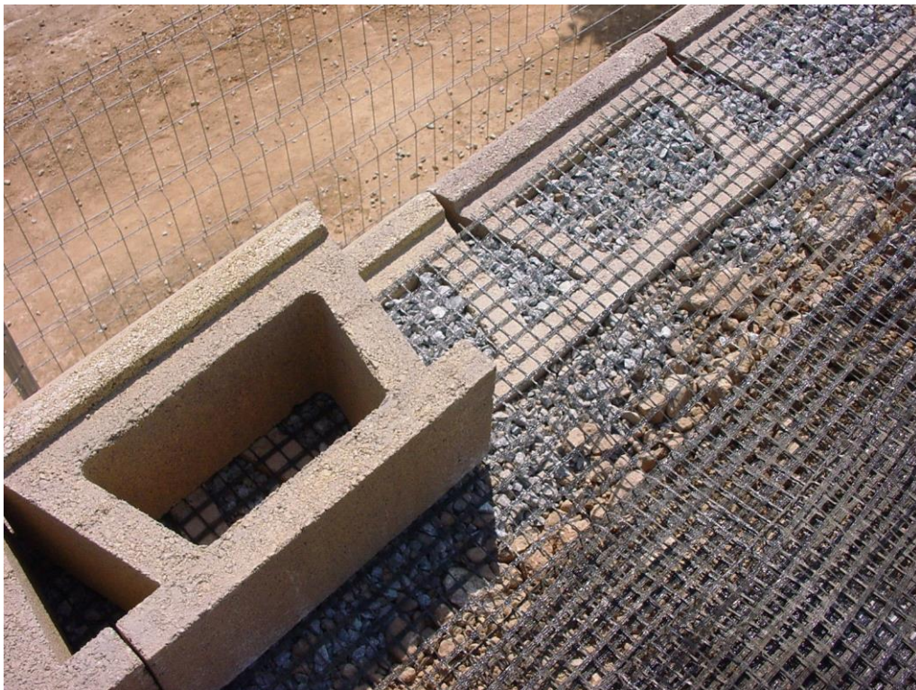
Figura 1. Muro de contención con la técnica de tierra armada.
