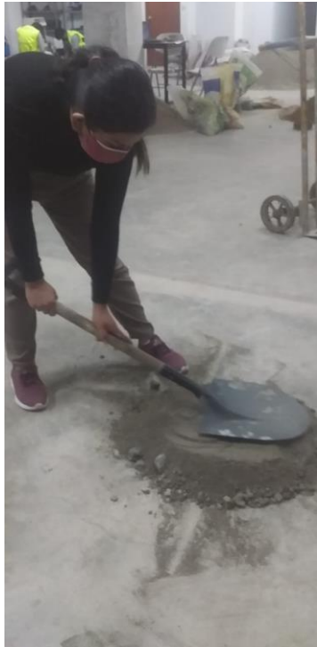
Figura 43. Mezclado del suelo
