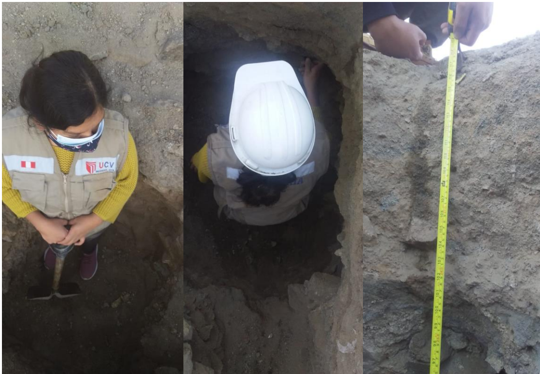
Figura 7. Ejecución de calicata 1mx1mx3m Fuente elaboración propia
