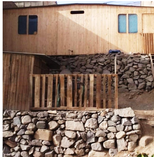
Figura 38. Vivienda 3 con cimentación de pircas
