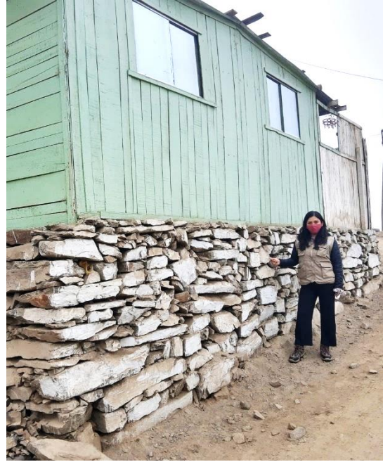
Figura 36. Vivienda 2 con cimentación de pircas
