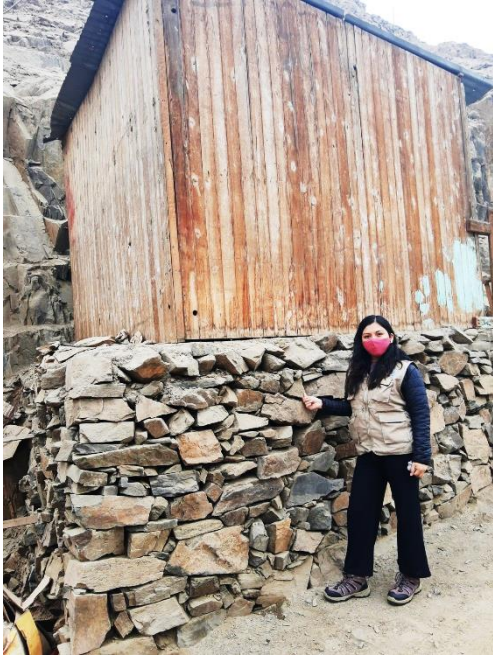
Figura 35. Vivienda 1 con cimentación de pircas
