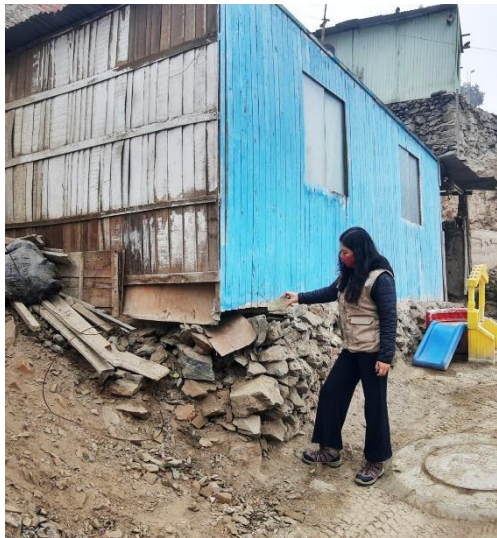
Figura 37. Vivienda 4 con cimentación pircas
