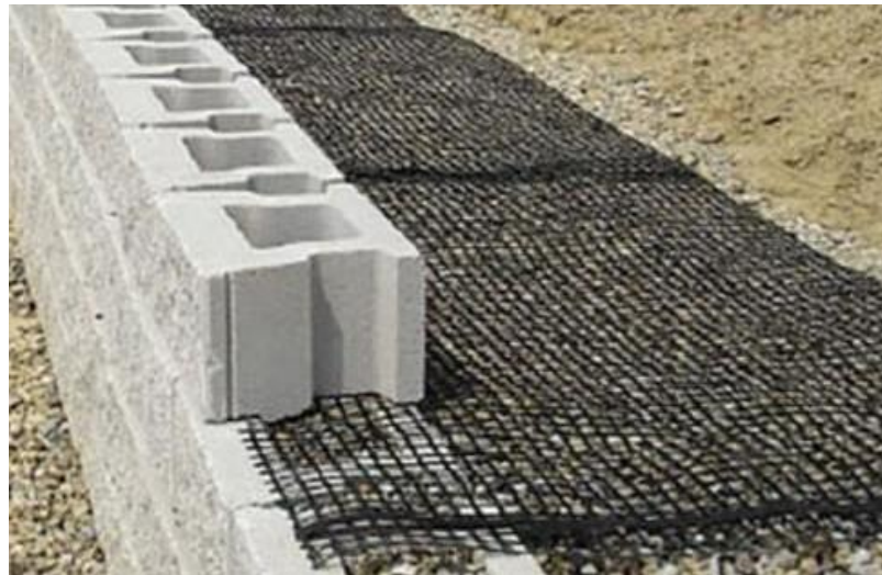
Figura 27. Colocación de geomalla para el refuerzo del suelo
