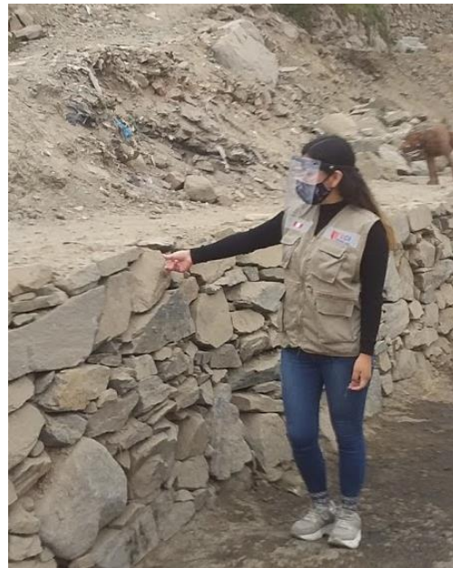
Figura 32. Muro de rocas
