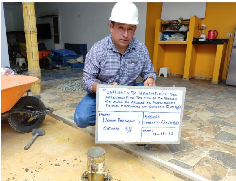
Foto N°02: asentamiento o Slump
