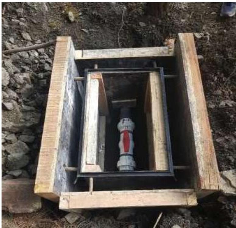
Imagen 9. Válvula de bola PVC de D=2".
