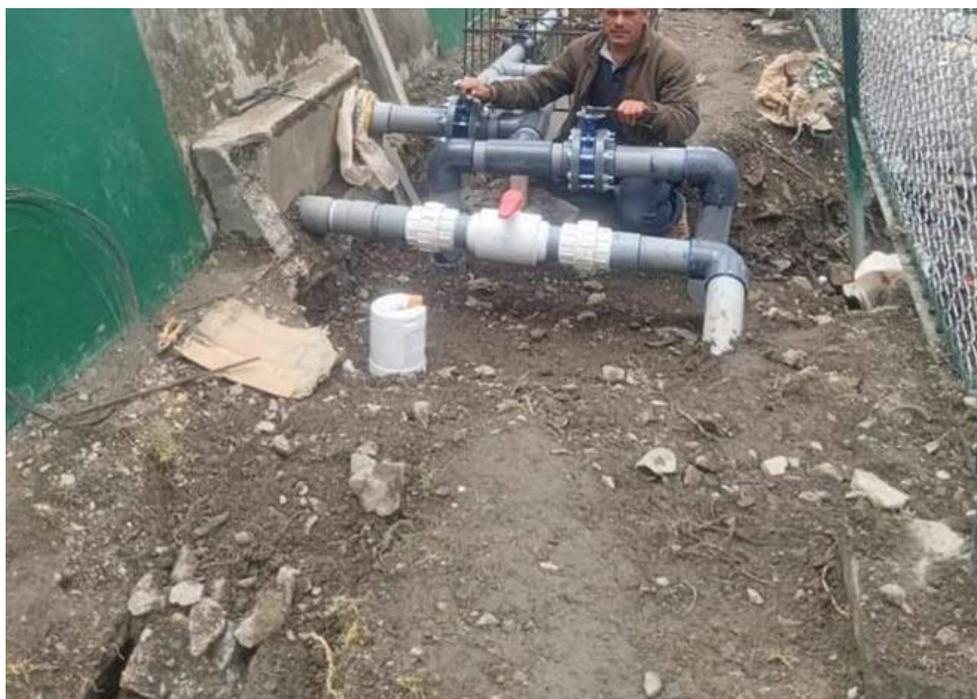
Imagen 7. Colocación de válvulas en reservorios (Tipo bola de D=4" y Tipo Mariposa con brida de PVC de D=4").
