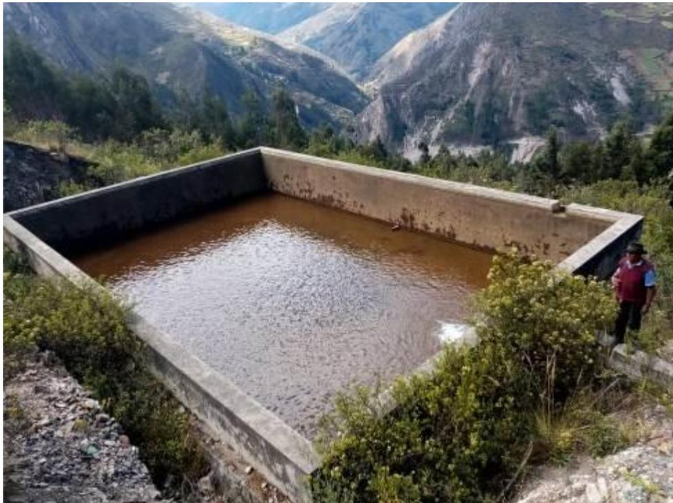
Imagen 3. Reservorio existente de  $V= 200 \text{ m}^3$ .
