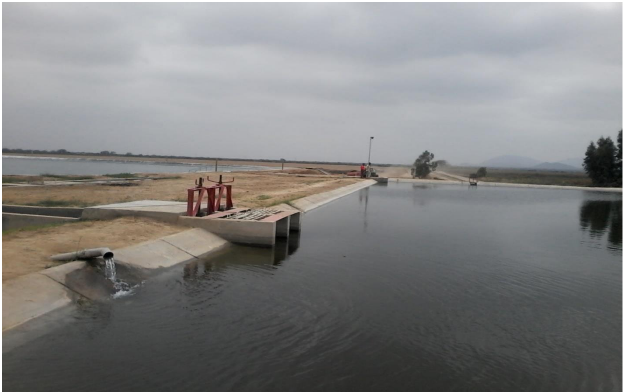
Union de reservorio 1 y 2
