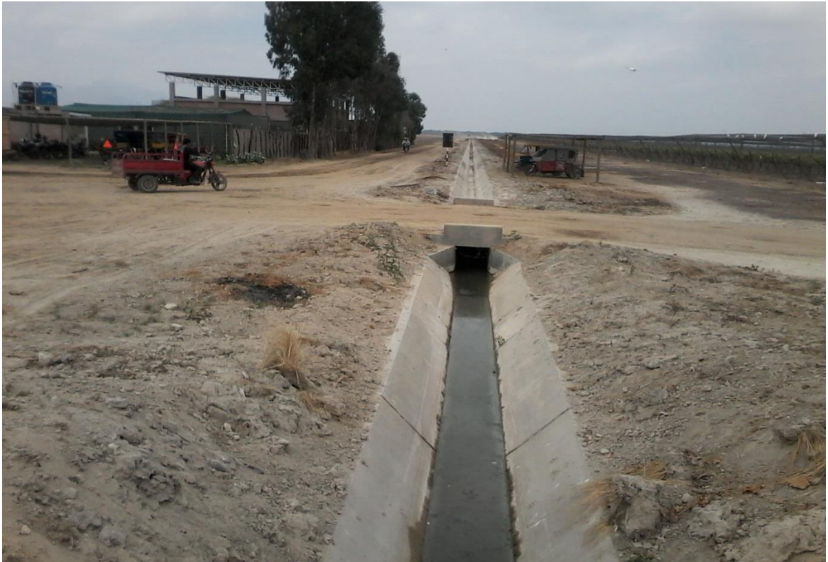
Canal de excesos de reservorio
